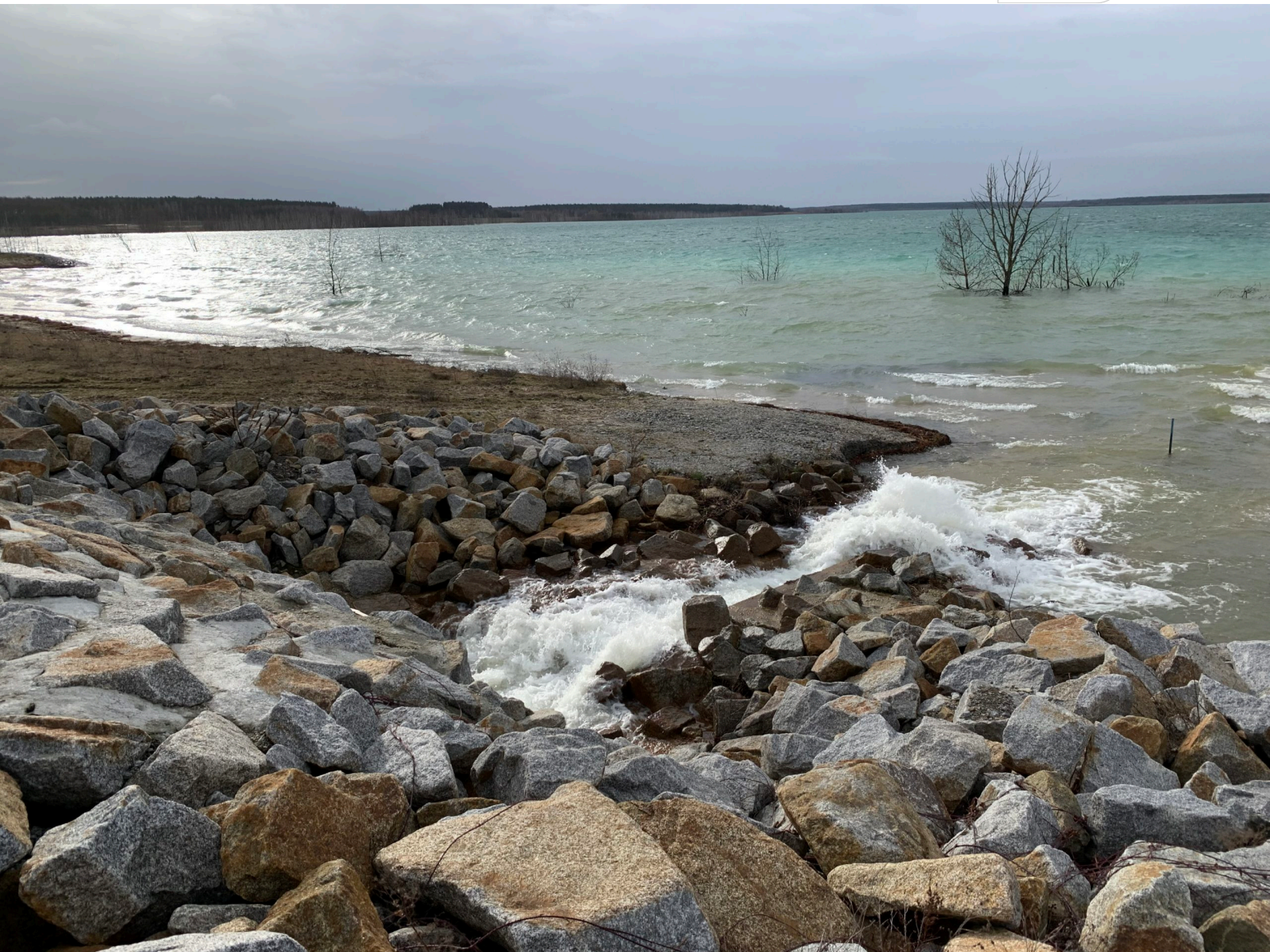
Wasser aus der Neiße kommt über den Oberen Landgraben zum Sedlitzer See
