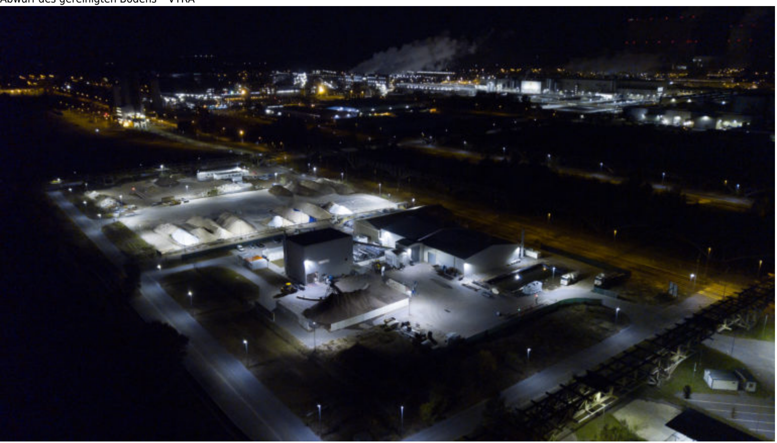
Vakuumthermische Reinigungsanlage Schwarze Pumpe
