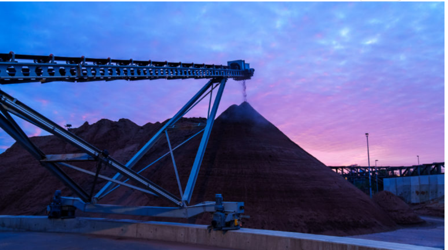
Abwurfanlage für gereinigten Boden
