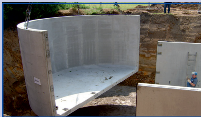
2007 erfolgt der Einbau einer Löschanlage.
