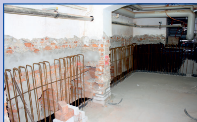
Abdichtung des Kellers durch Einbau einer Weißen Wanne.
