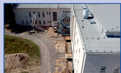
Befestigung der Bühnenzufahrt und der Feuerwehrumfahrt um das Gebäude.
