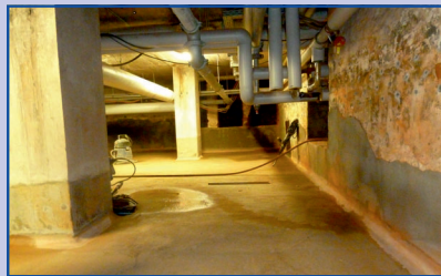
Teilverfüllung des ehemaligen Heizungskellers unter dem Anbau Ost.
