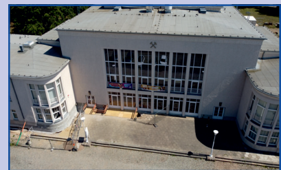
Erneuerung der Freitreppe am Haupteingang mit barrierefreiem Zugang.
