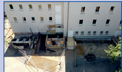
Erneuerung des Bühneneingangs mit Stand der Arbeiten 2022.
