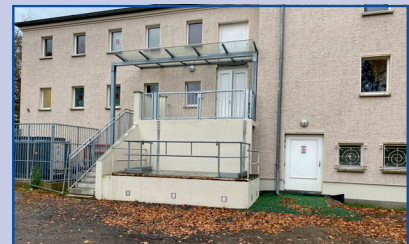
Der neue Bühneneingang wurde 2024 fertiggestellt.
