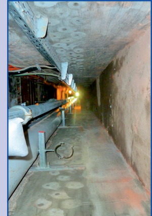
Versorgungskanäle für Leitungstrassen im teilverfüllten Bereich des Kellers unter dem Anbau Ost.
