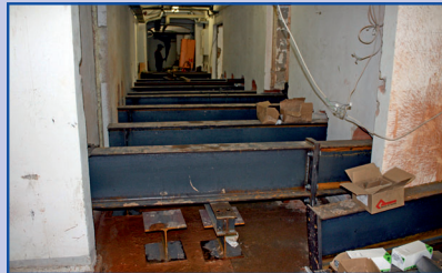
Unterfangen der Wände und Pfeiler mit Stahlträgern als Hilfskonstruktion für den Einbau der wasserundurchlässigen Bodenplatte.
