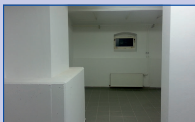
Der fertig sanierte, abgedichtete Keller nach Einbau der Weißen Wanne.
