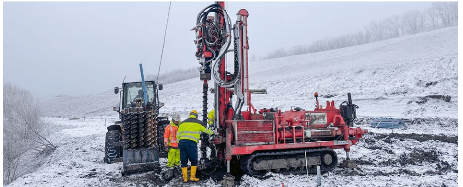
Setzen von Bohrlöchern für die Schonende Sprengverdichtung an der östlichen Rutschungsflanke
