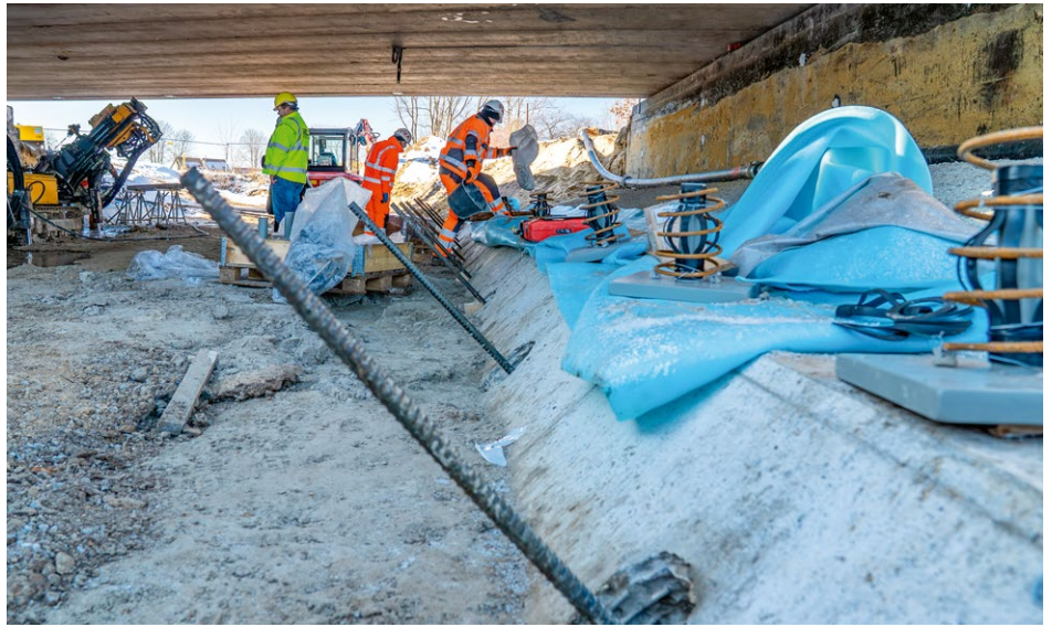
Brückensicherung im Bereich des Ableiters des Sedlitzer Sees
