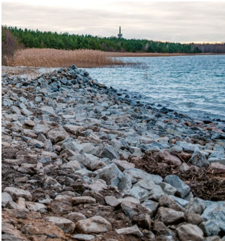
Mit Wasserbausteinen wird das Ufer gegen Wellenschlag gesichert.
