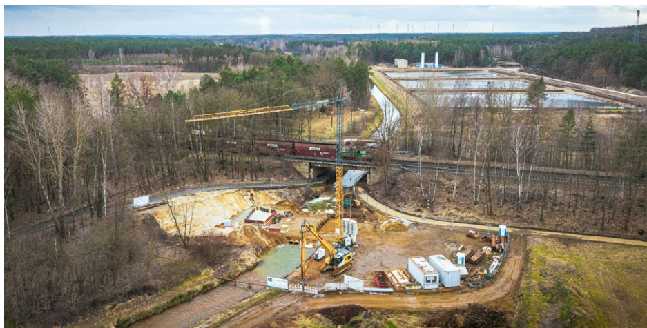
Hier entsteht die neue Wirtschaftsbrücke. Die alte Brücke hinter den Bahnschienen wird abgerissen. Im Hintergrund ist die Modulare Wasserbehandlungsanlage Burgneudorf zu sehen.
