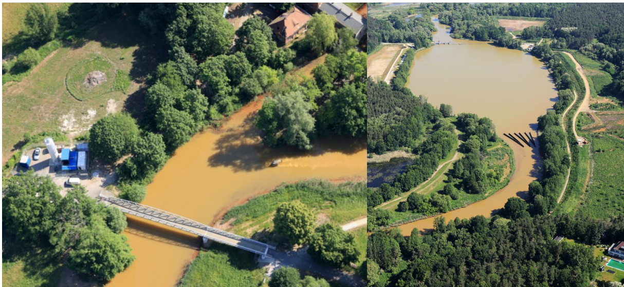
Bild 1: Wasserbehandlungsanlage an der Spree mit Kalkstation (TA1, links) und Dosierstelle für das Flockungshilfsmittel am Verteilerbauwerk der Vorsperre Bühlow (TA2, rechts). (Fotos: Rauhut, Juni 2023).
