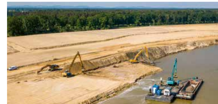
Rütteldruckverdichtung am Groß Särchener Ufer, 2019
