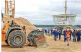
Baustellentag am Knappensee, 2022
