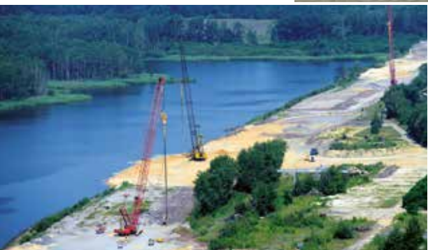
Rütteldruckverdichtung an der Ost- böschung des Silbersees, 2013
