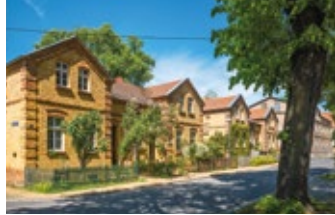
Sanierte Arbeiterhäuser in der Glaswerksiedlung in Annahütte, 2020
