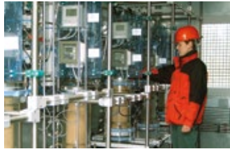
Wasserreinigungsanlage während der Sanierung des Restlochs 4 in Annahütte, 2004
