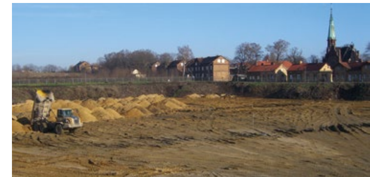
Restloch 4 in Annahütte zu Beginn der Sanierung, 2007 Unsanieretes Restloch 4 in Annahütte, 2007
