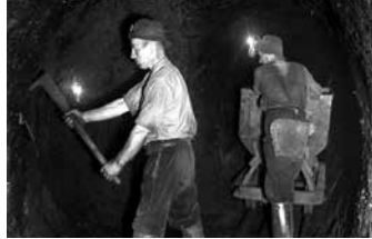
Arbeiten in einer untertägigen Entwässerungsstrecke, um 1920
