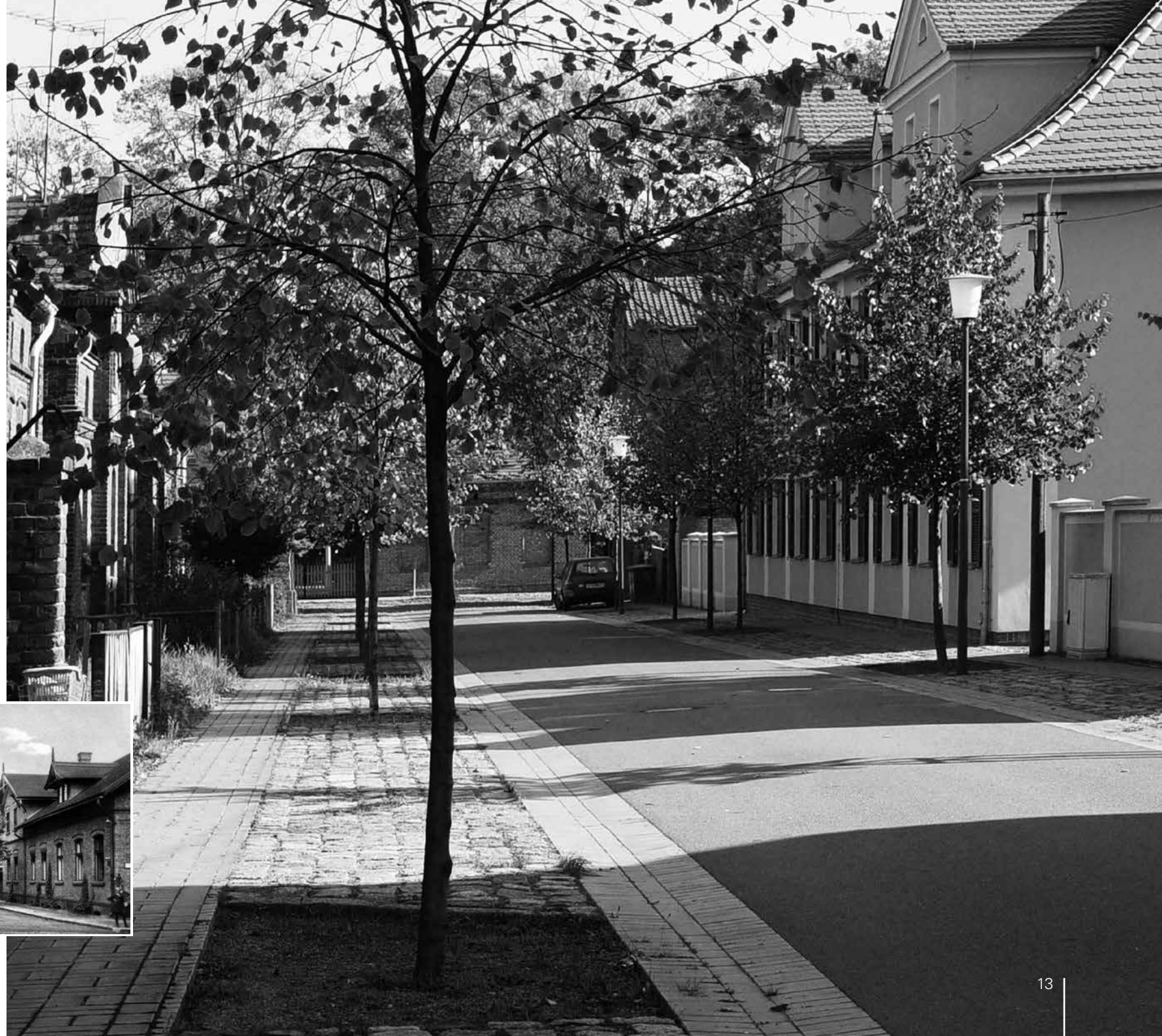
Sanierte Glasarbeitersiedlung Annahütte, 2004
