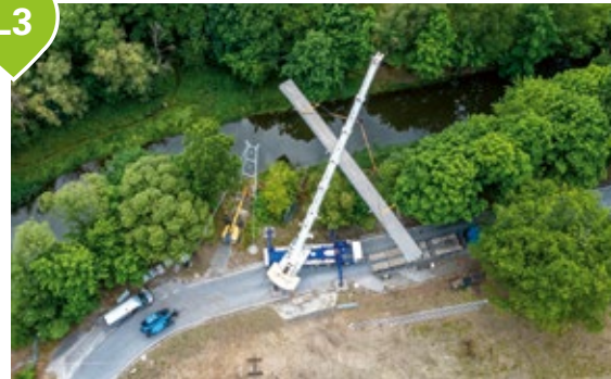
Montage des Brückenneubaus über das Schwarzwasser
