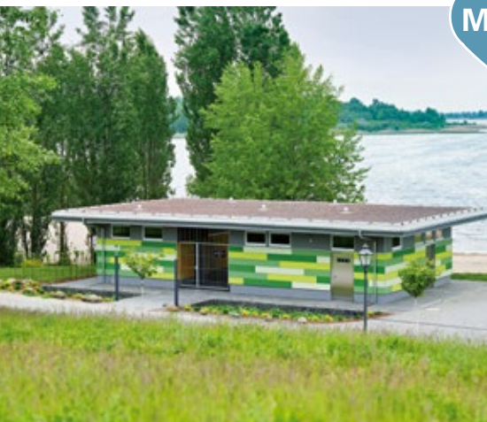
Neubau der Überwachungs- und Servicestation am Badestrand Hayna, 2024
