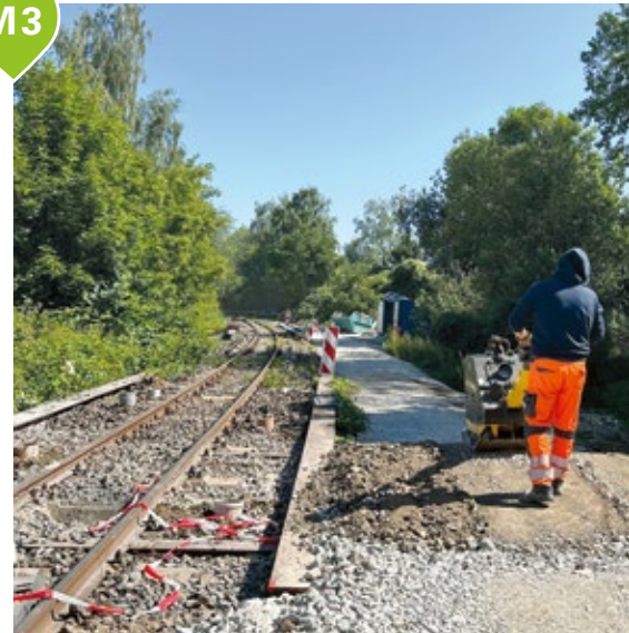
Gleisbauarbeiten an der Kohlebahn
