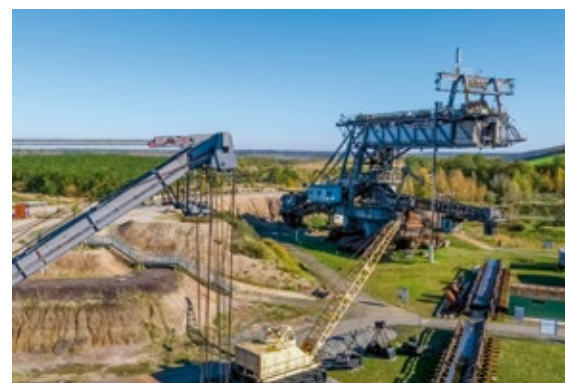
Blick vom Absetzer zum Bagger 1547
