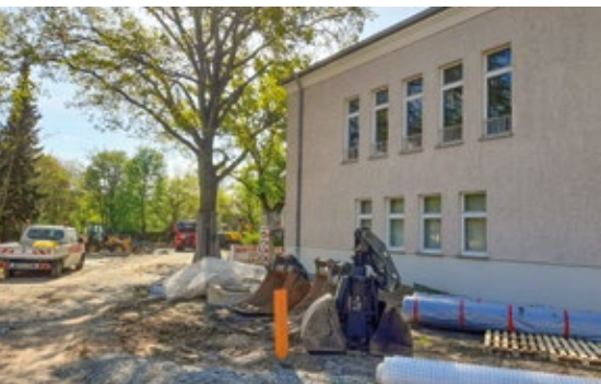
Parkplatzerneuerung am Kulturhaus
