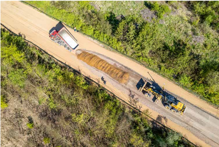
Während des Ausbaus des ca. 1 km langen Wegs im Waldgebiet Neue Harth
