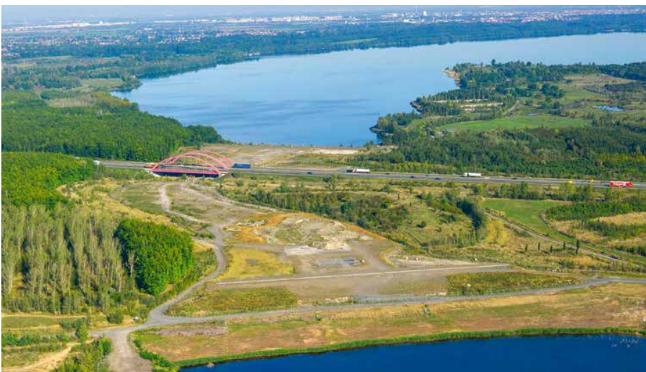
Die Trasse für den Ableiter vom Zwenkauer See ist bereits vorbereitet.
