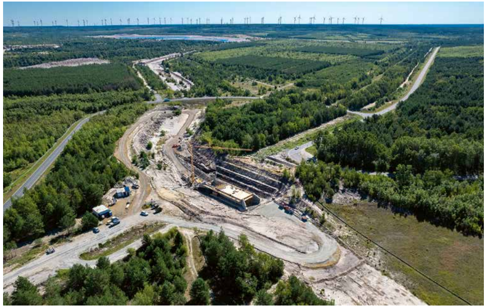
Die neue L60-Brücke wird die Vorflutverbindung zwischen Restloch 113 und Restloch 75/99 bei Lauchhammer überspannen.
