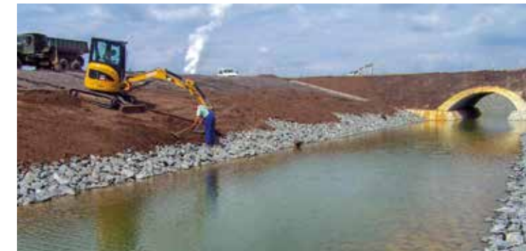
Herstellung der Gewässer-Verbindung zwischen Hainer See und Kahnsdorfer See, 2013
