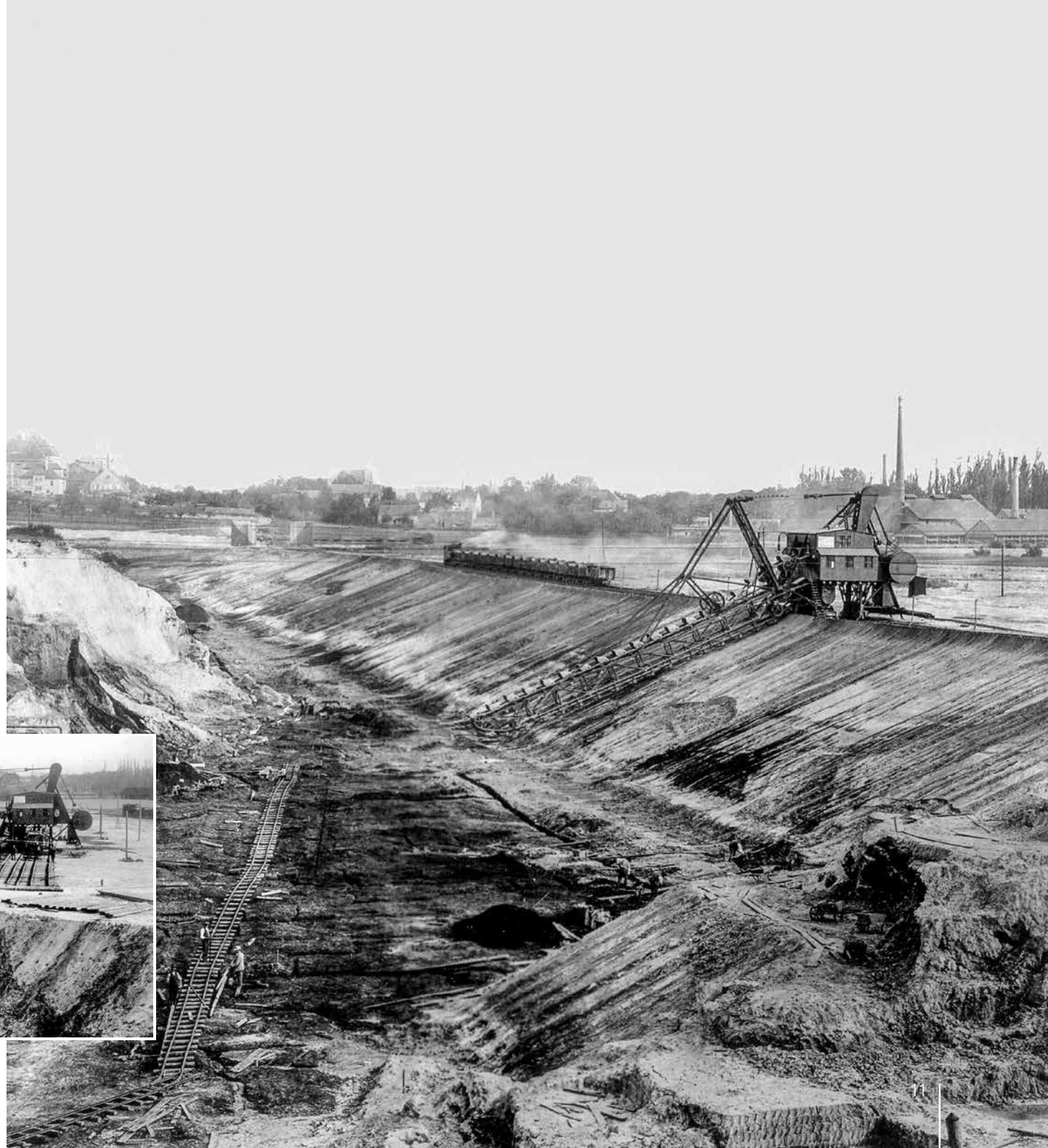
Eimerkettenbagger E 300 Nr. 5 der MFB im Tagebau Witznitz I, im Hintergrund die Stadt Borna, 1912
