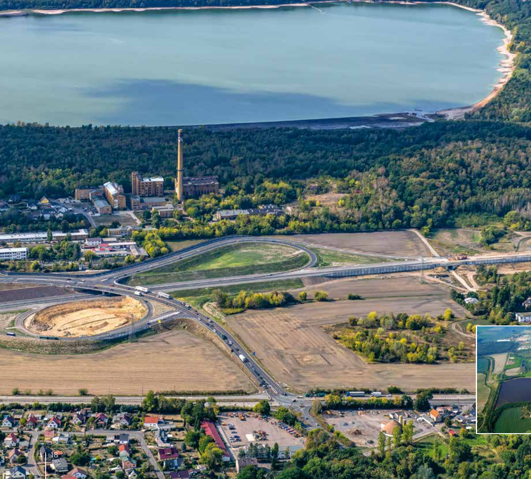
Speicherbecken Witznitz, im Vordergrund die stillgelegte Briquettfabrik Witznitz und die noch im Bau befindliche BAB 72, 2018
