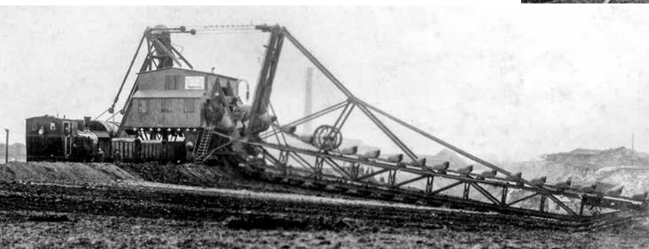
Eimerkettenbagger im Tagebau Witznitz I, 1919
