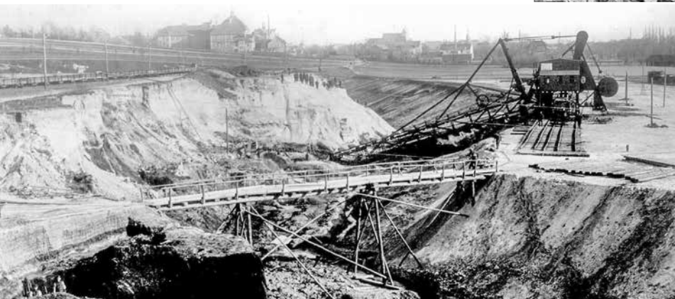
Eimerkettenbagger E 300 Nr. 5 im Tagebau Witznitz I bei der Aufschlussbaggerung, 1911
