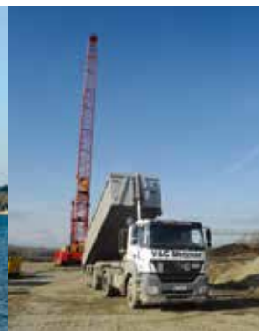
Befahrung des Knappensees, 2010 Sanierungsmaßnahmen am Silbersee, 2012
