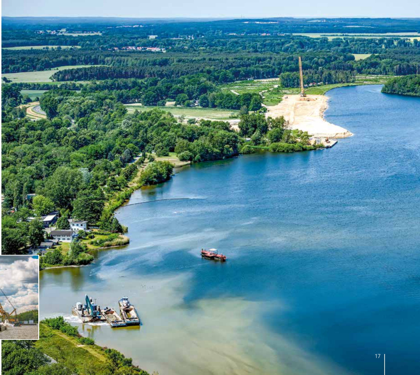
Rütteldruckverdichtung am Groß Särchener Ufer, 2019
