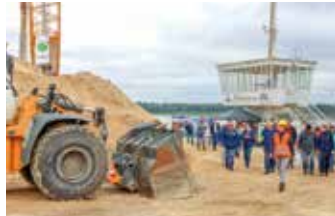
Baustellentag am Knappensee, 2022
