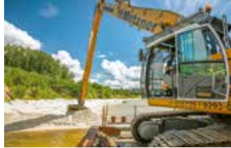
Ufersanierung an der Hochkippe, 2023
