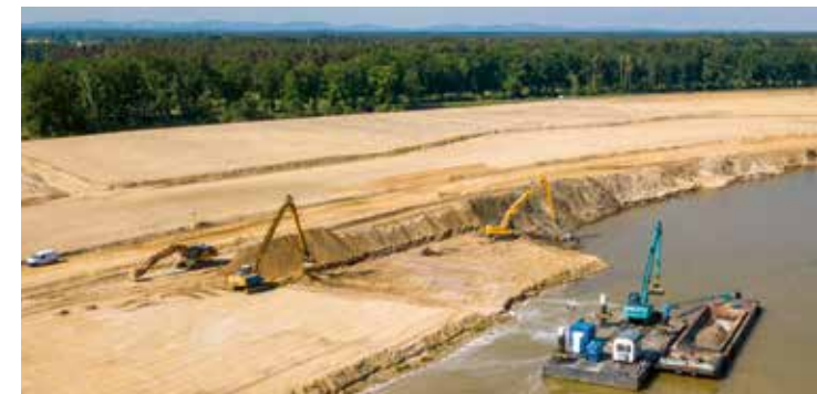
Ufersanierung am Knappensee, 2022 Einsetzstelle in Groß Särchen, 2023
