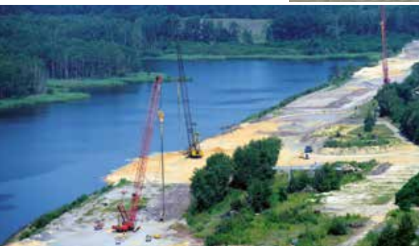
Rütteldruckverdichtung an der Ost- böschung des Silbersees, 2013
