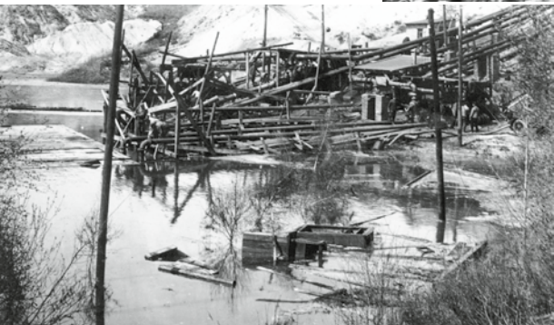
Wassereinbruch im Tagebau Werminghoff I, 1941
