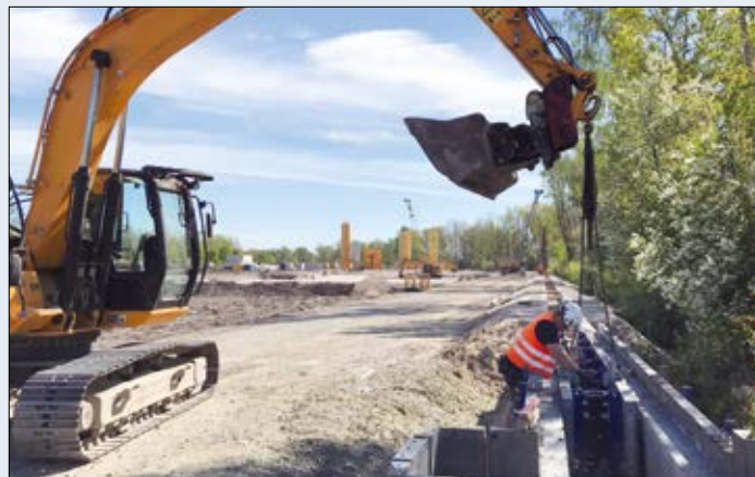
Bau der Dichtwand um die künftige WBA Plessa im Jahr 2019
