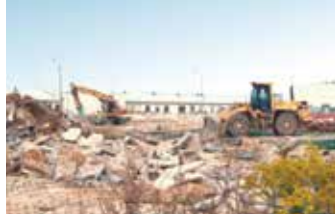
Abbruch der Tagesanlagen Merseburg-Ost, 1994
