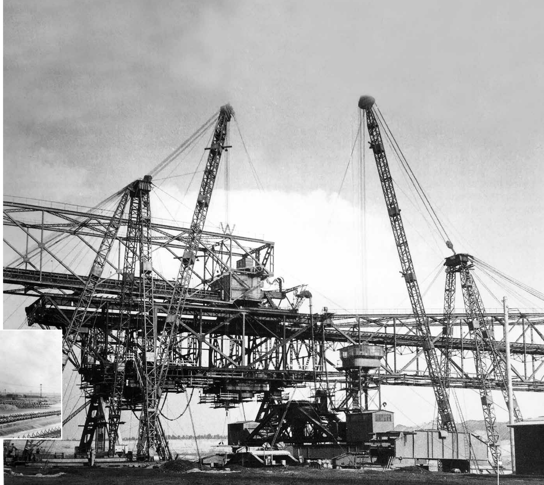
Umbau der Abraumförderbrücke AFB 45-18 für den Tagebau Böhlen, später Zwenkau, Verkürzung der Mittelstütze um drei Meter, 1962
