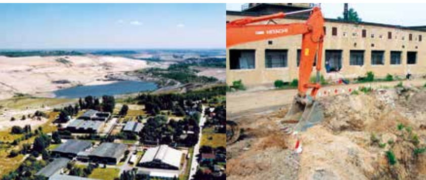
Einstige Tagesanlagen Gröbern, 2003
