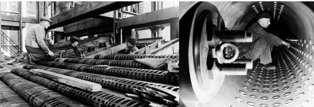
*Formleger bei der Herstellung von Stempeln für Briketts in der Brikettfabrik Marga in Brieske, um 1925*
