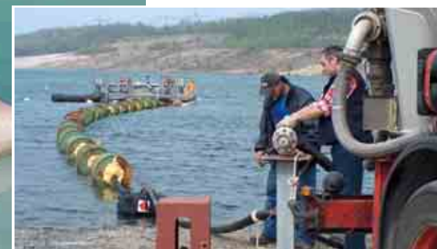
Einleitung von Soda in den Bockwitzer See zur Gewässerneutraliation, 2005
