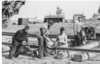
Gleisbauarbeiten bei der Vorbereitung des Aufschlusses des Tagebaus Borna-Ost, 1959
