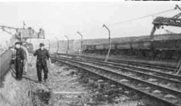
Aufschlussarbeiten im Tagebau Borna-Ost, 1960
