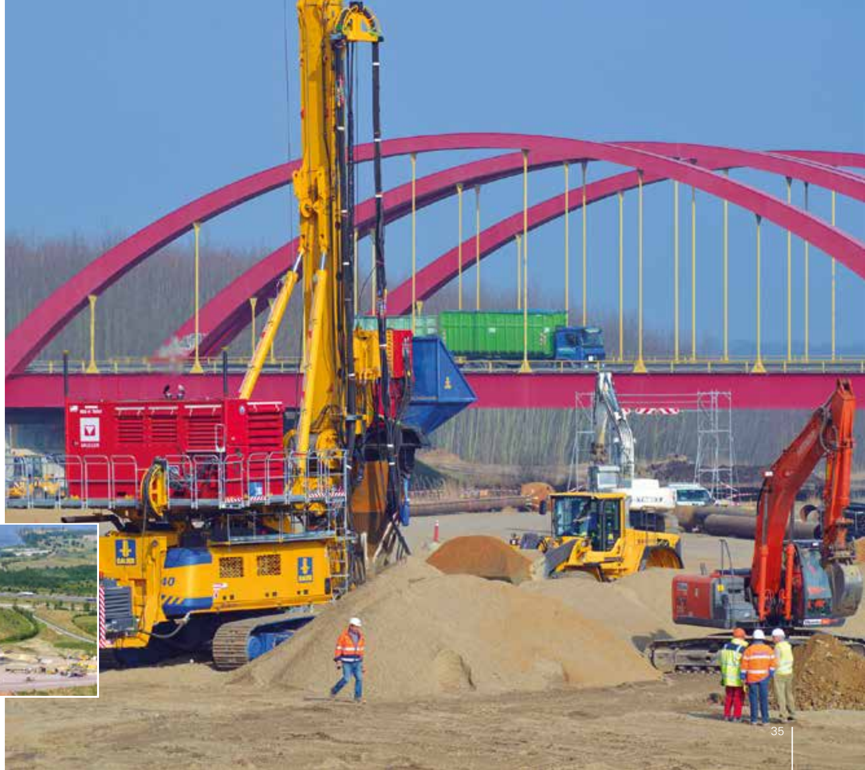
Baustelle des Harthkanals mit der Brücke der BAB 38, 2015
