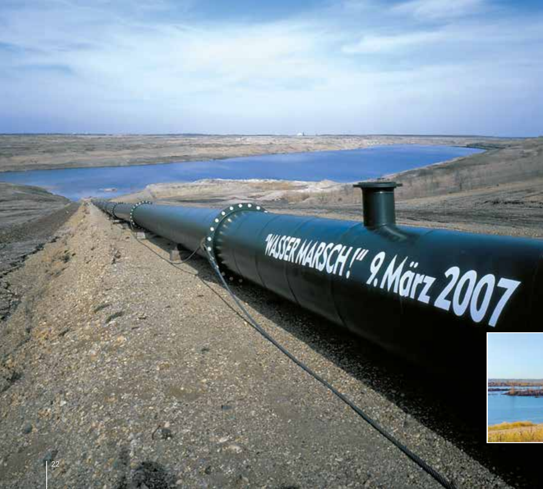
Flutungsleitung zum Restloch Zwenkau, 2007
