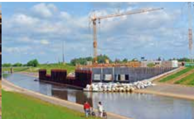
Arbeitsberatung beim Bau der Hochwasserentlastung am Zwenkauer See, 2011
