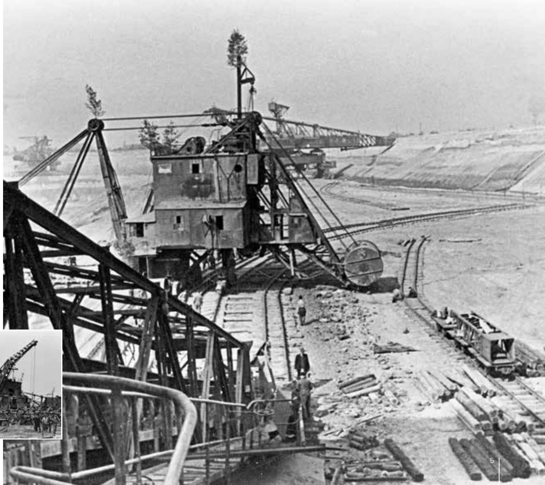
Aufschlussbaggerung im Tagebau Böhlen, um 1921
