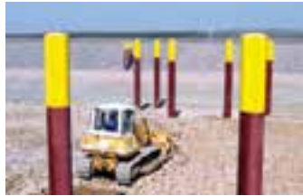
Errichtung des Hafenbeckens Zwenkau, 2009
