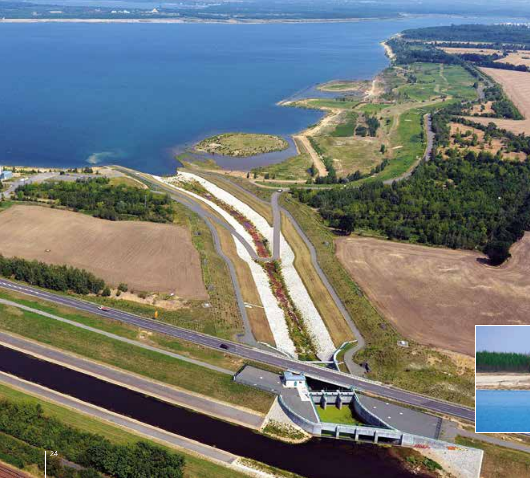
Einlassbauwerk der Hochwasserentlastung der Weißen Elster am Standort Zitzschen am Zwenkauer See, 2015
