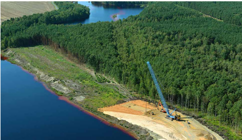
Sanierungsarbeiten der LMBV werden fortgeführt.
