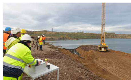
Die ersten Meter sind geschafft – Die Verfahrenskonzeption funktioniert in der Praxis.
