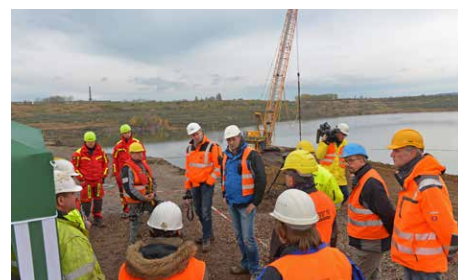
Die Anspannung ist groß: Einweisen in die Sicherheitsanforderungen vor dem Verfahren des Seilbaggers.
