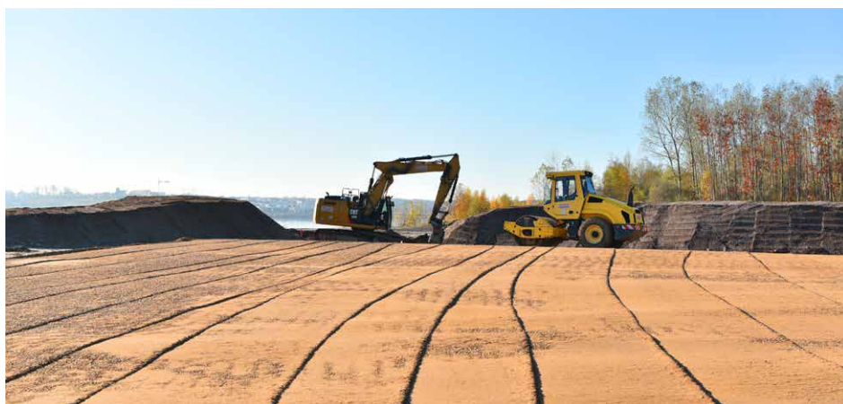
Die großflächig aufgeschütteten Erdmassen stabilisieren den Baugrund.
