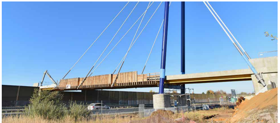
Pylonbrücke bei Gaschwitz: Alte Wegeverbindung wird wiederhergestellt.
