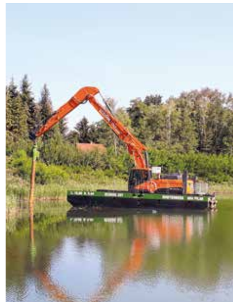
Mit Hilfe von Amphibientechnik wird die Kippe vom Wasser aus verdichtet.
