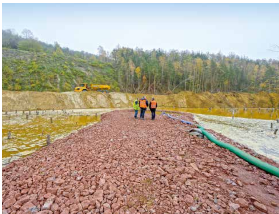
Begutachtung der offenen Wasserfläche durch Abteilungsleiter Dietmar Onnasch, Projektmanager Dietmar Wollnitza und den Polier der bauausführenden Firma MEBAG
