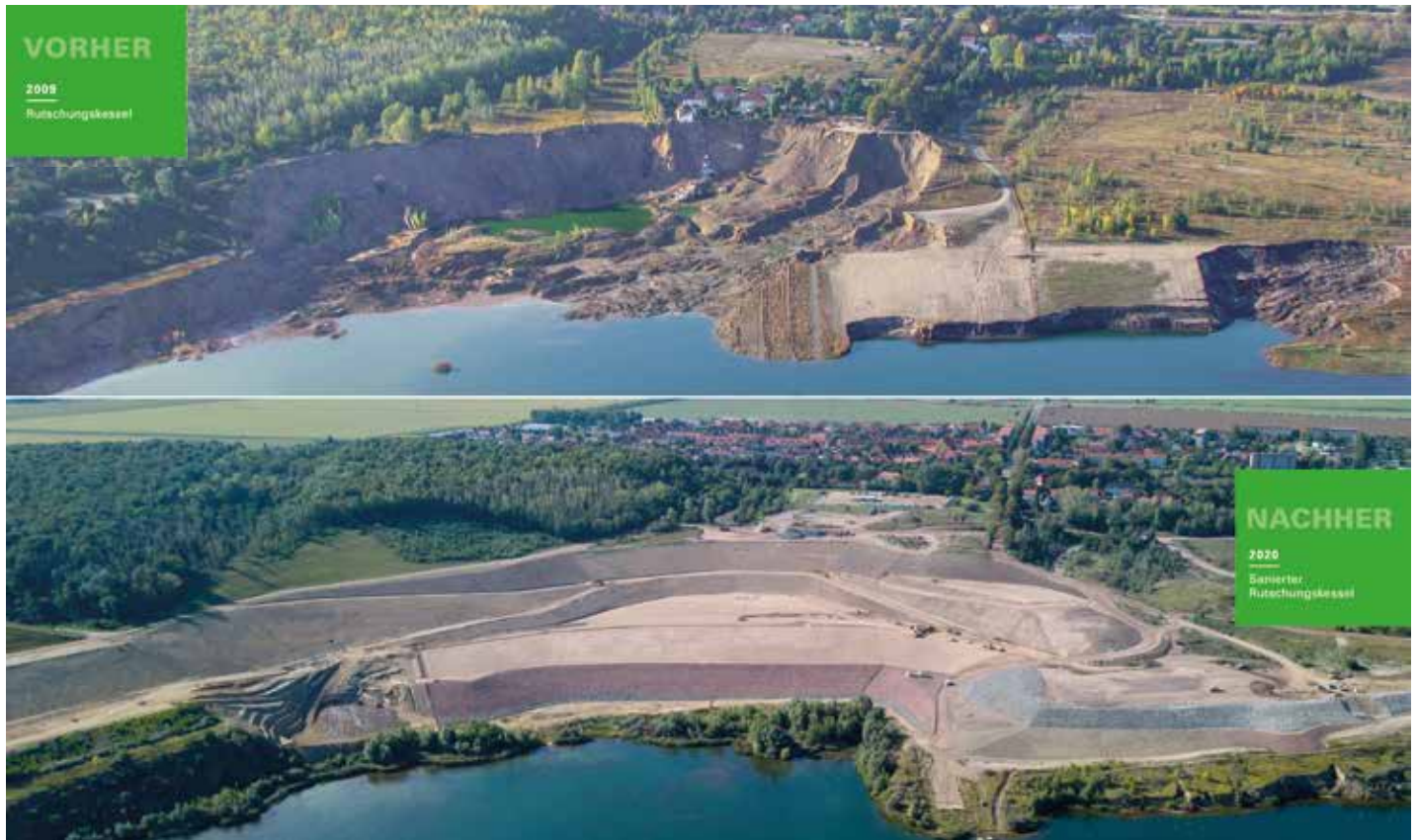
Der Hauptrutschungskessel am Concordia See im Jahr der Böschungsbewegung 2009 und nach der Sanierung 2020 im Vergleich
