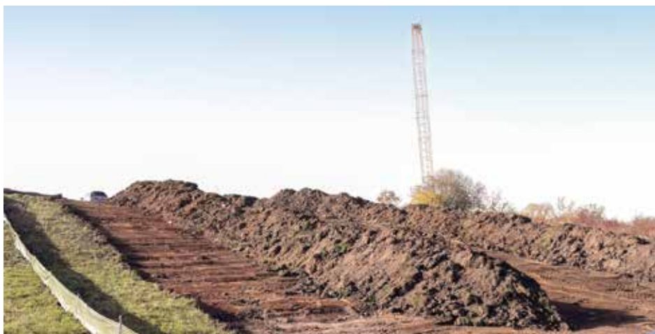
Mit der Sanierung soll die uneingeschränkte Nutzung des Speichers gewährleistet werden.
