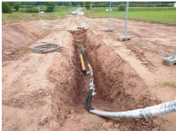
Bauarbeiten für die Mess- und Regeltechnik der Laugenleitung
