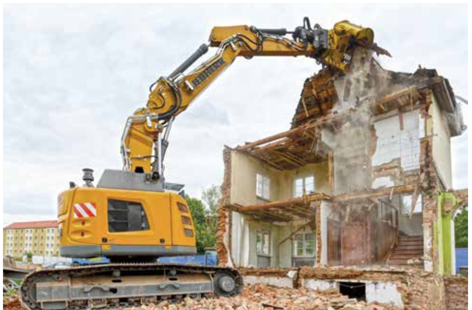
Voraussichtlich bis zum Jahresende wird der Rückbau der belasteten Gebäude in der Straße der Chemiewerker und der Talstraße dauern.
