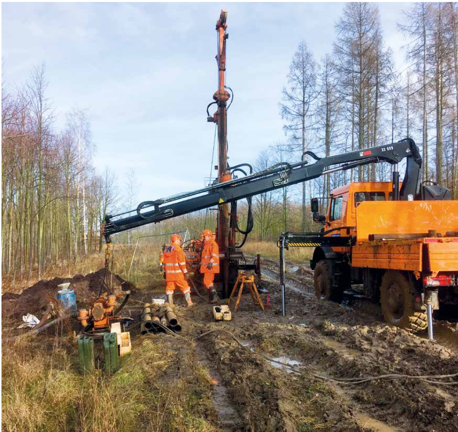
Bohrerkundung im Sicherungsbereich der künftigen Autobahntrasse
