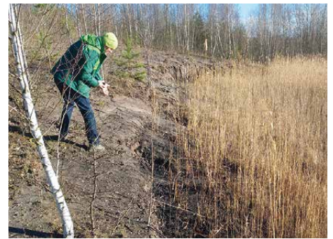
Böschungsabbruch im Bereich der „Mure Stöbnitz“
