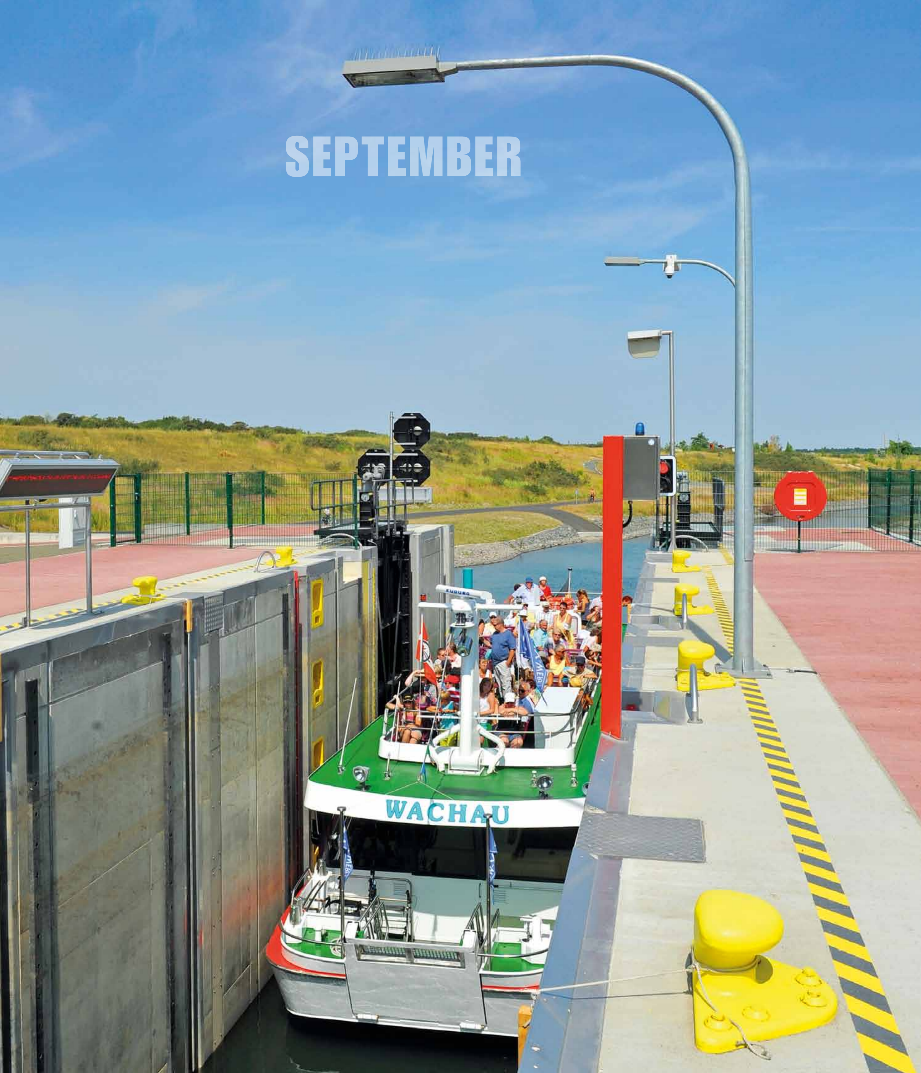
Durchfahren der Kanupark-Schleuse zum Markkleeberger See
