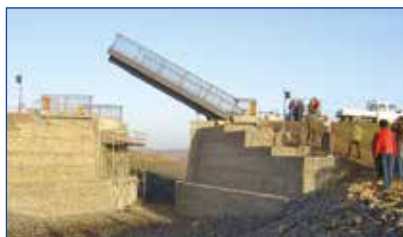
Hubbrücke über den Kanal
