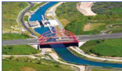
Kanal mit Autobahnbrücke A 38
