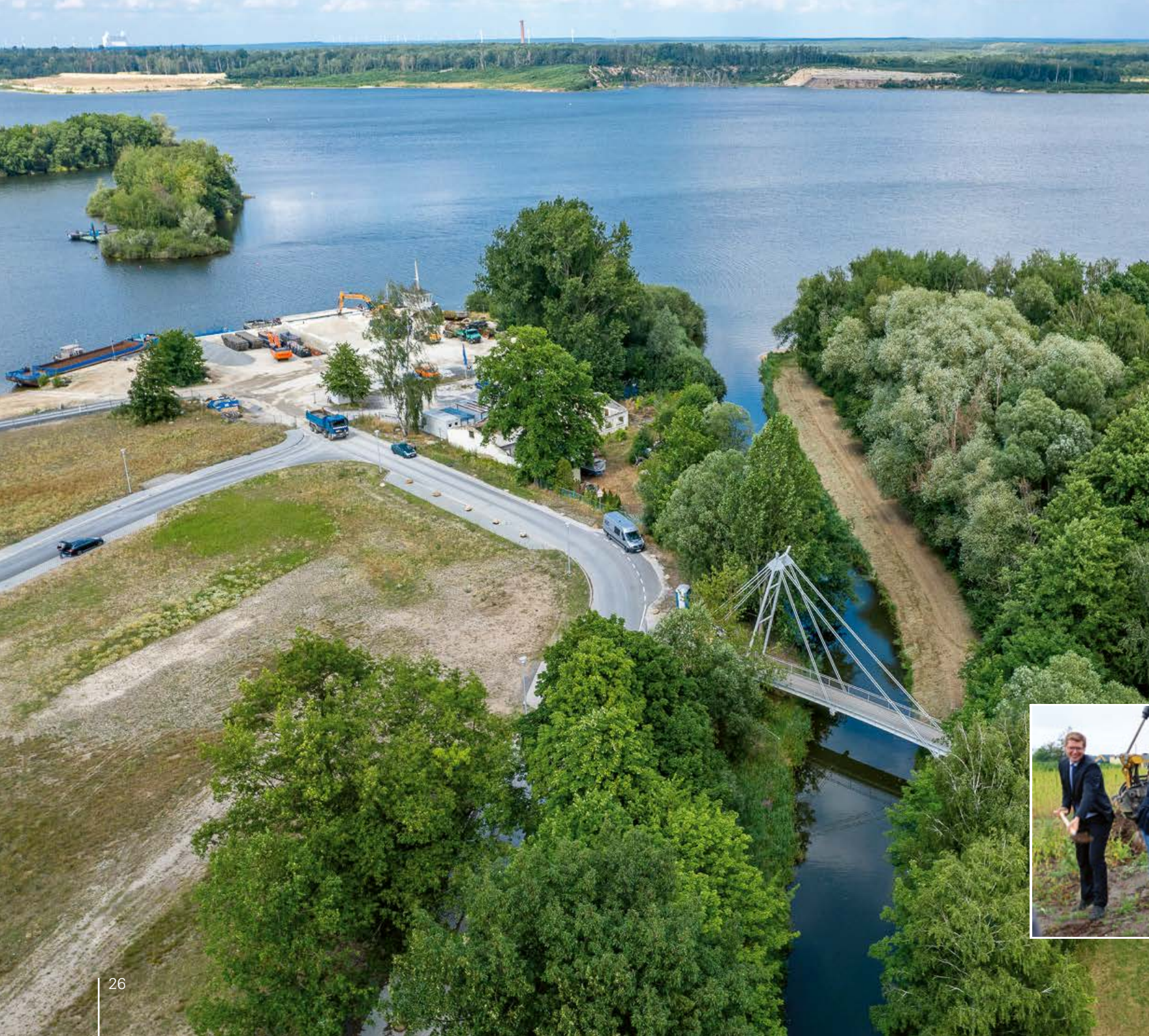
Blick über den See mit neu erschlossenen Fläche für das entstehende Vereinszentrum und der neuen Rad- und Fußgängerbrücke, 2023
