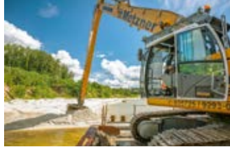
Ufersanierung an der Hochkippe, 2023
