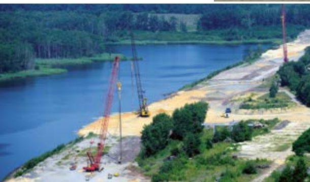
Rütteldruckverdichtung an der Ost- böschung des Silbersees, 2013
