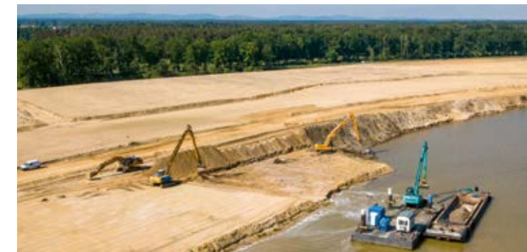
Ufersanierung am Knappensee, 2022 Einsetzstelle in Groß Särchen, 2023
