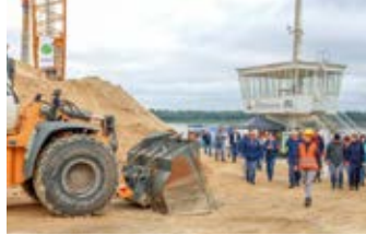
Baustellentag am Knappensee, 2022
