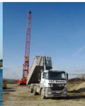
Befahrung des Knappensees, 2010 Sanierungsmaßnahmen am Silbersee, 2012
