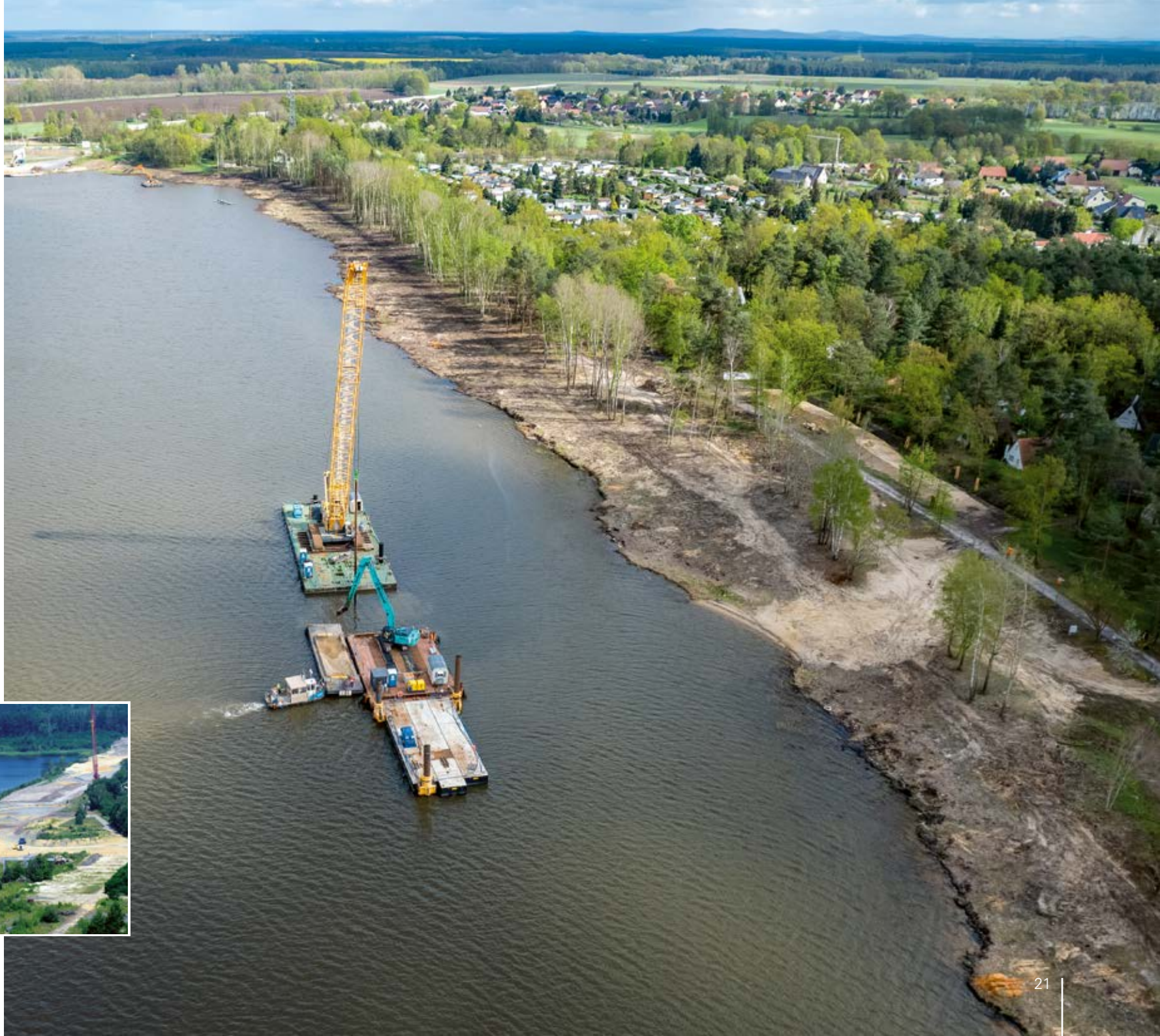
Arbeiten zur Sicherung des Friedersdorfer Strandes am Silbersee, 2024
