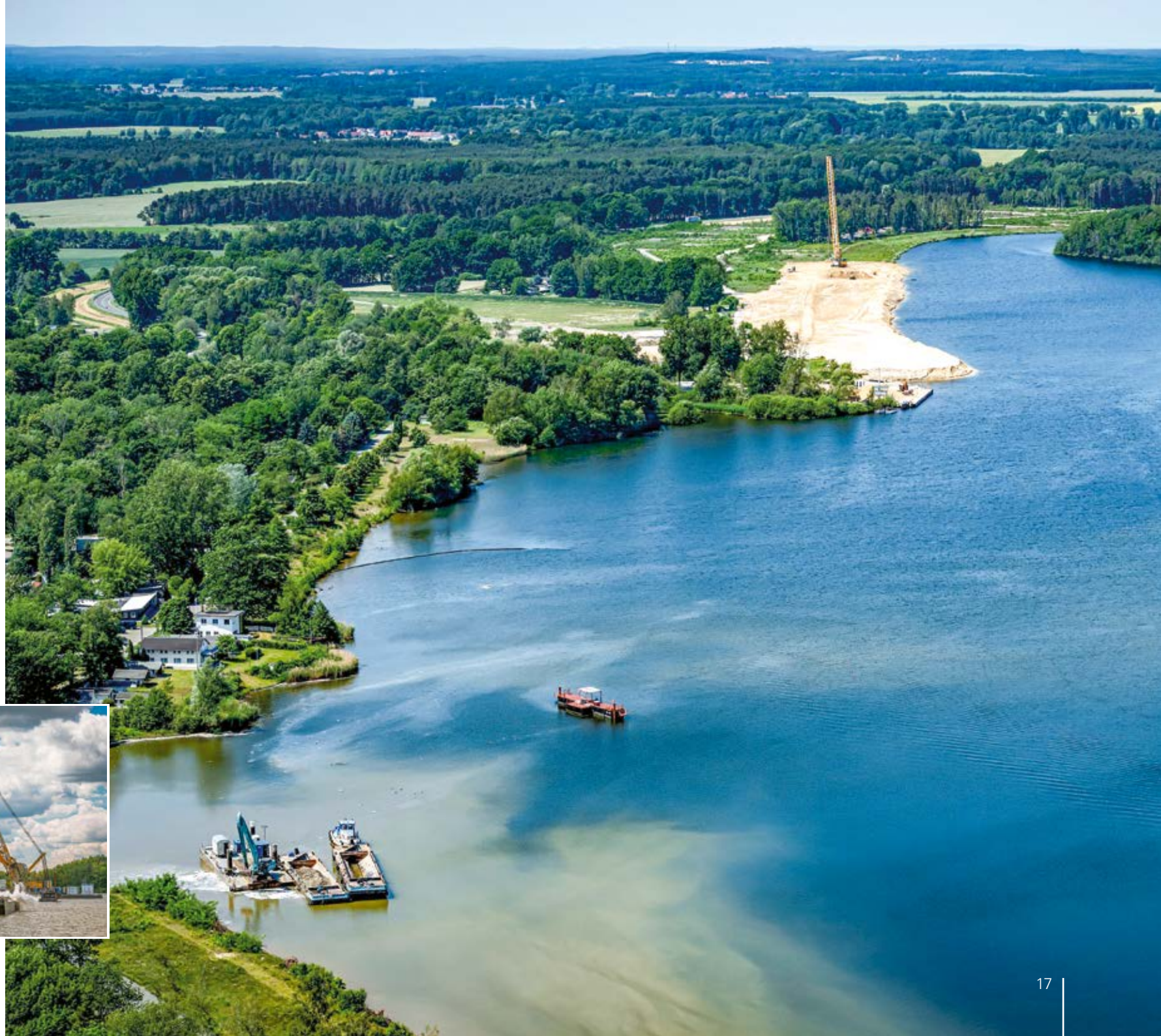
Rütteldruckverdichtung am Groß Särchener Ufer, 2019
