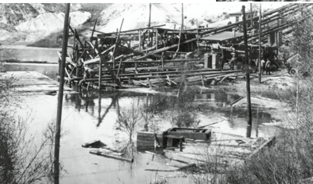
Wassereinbruch im Tagebau Werminghoff I, 1941
