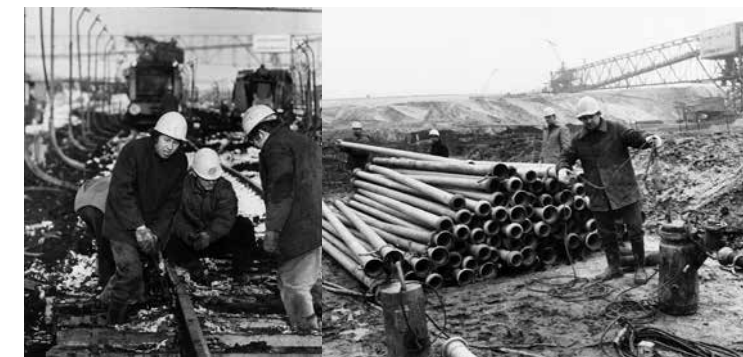
Gleisbau für die Grubenbahn im Tagebau Seese-West, 1974
