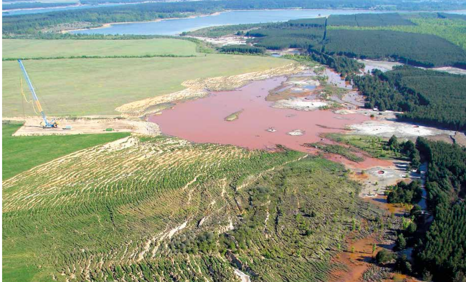
Grundbruch im Bereich der Kleptna-Niederung, 2011
