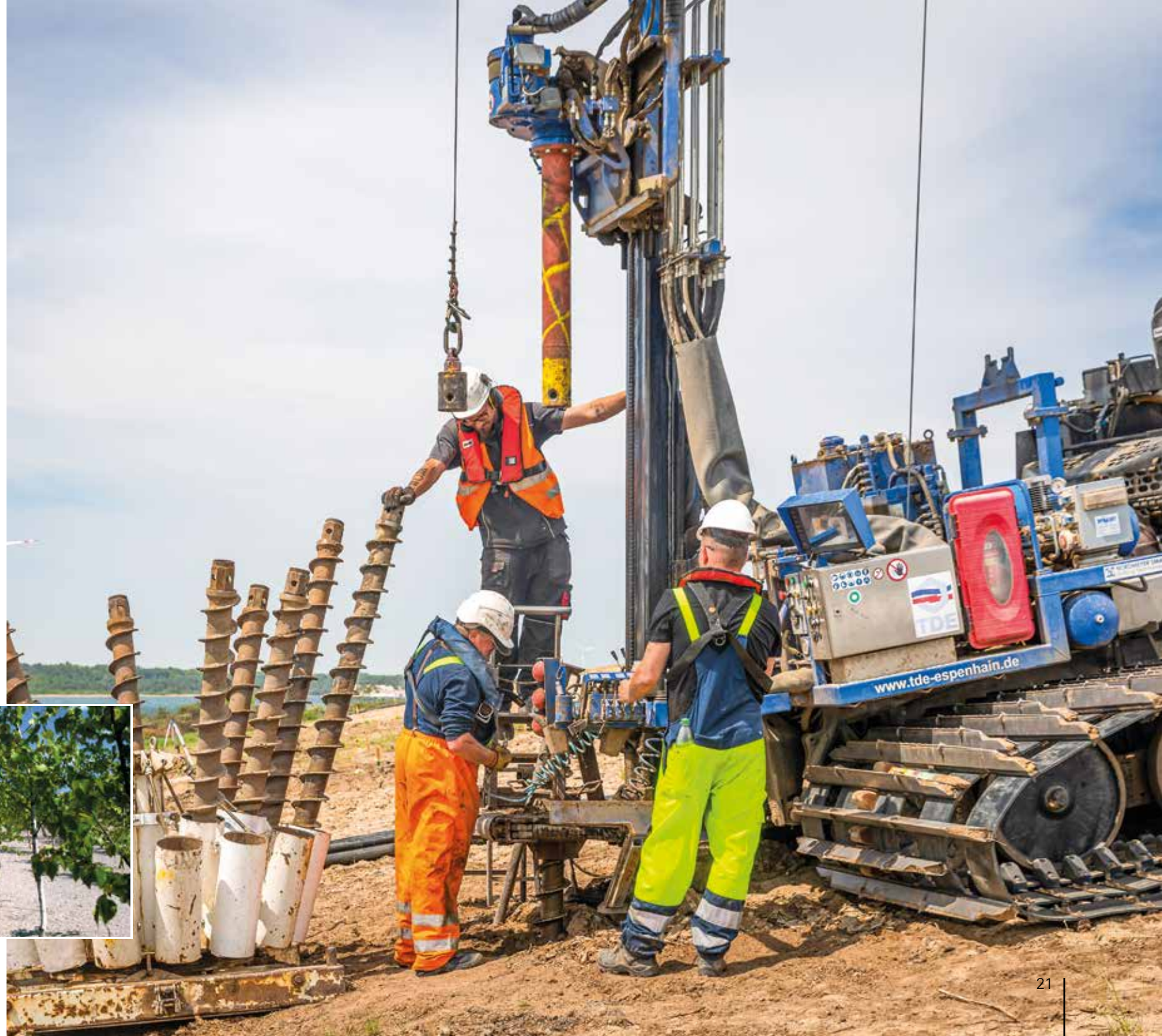
Vorbereitung der Schonenden Sprengverdichtung am Bischdorfer See, 2023
