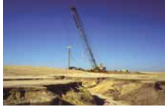
Sanierungsarbeiten im ehemaligen Tagebau Seese-Ost, 2004
