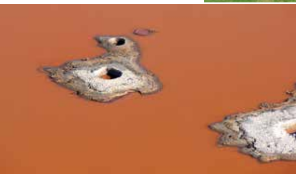
Strudellöcher nach dem Grundbruch in der Kleptna-Niederung, 2011
