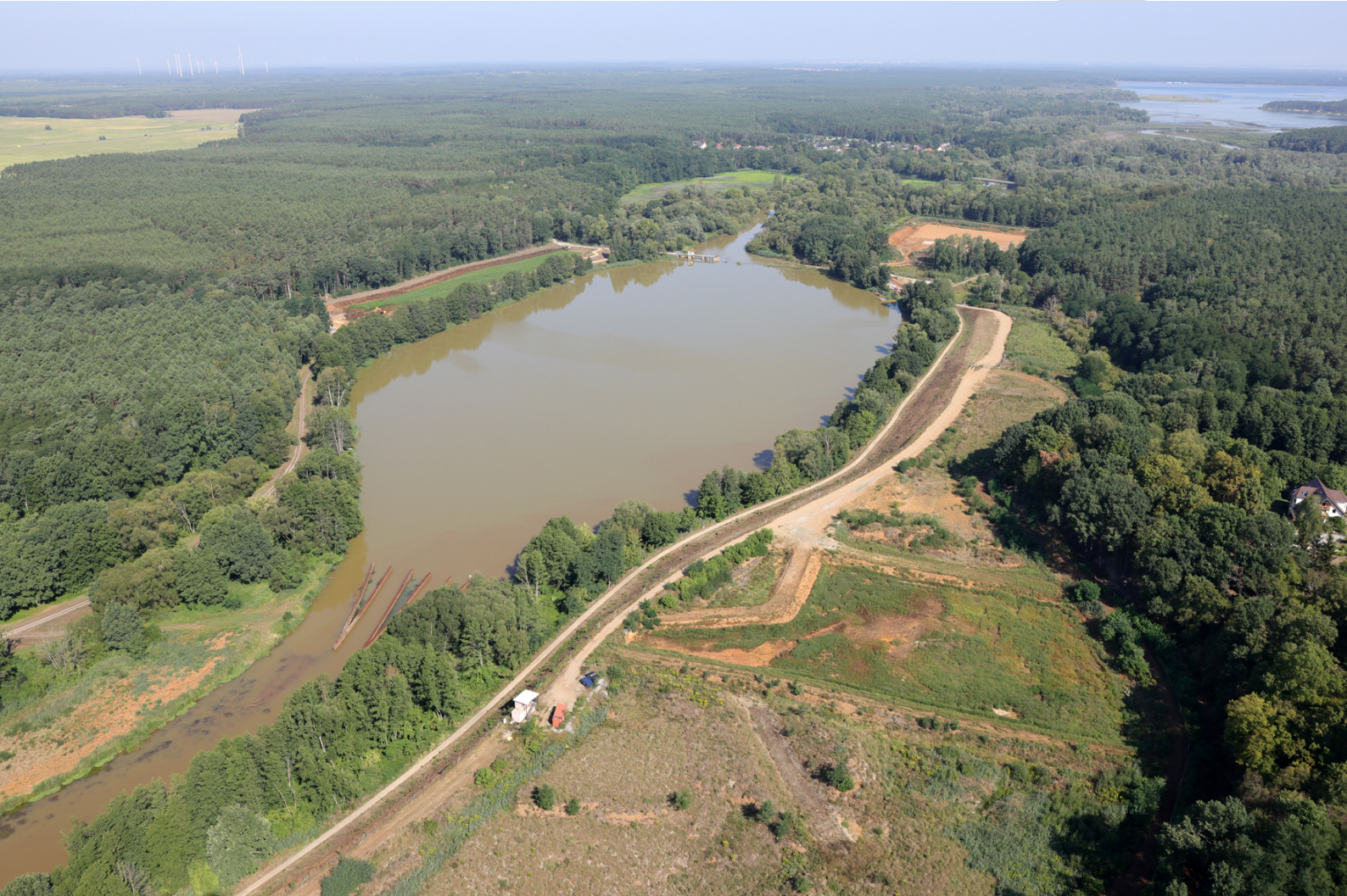
Sedimentationsbecken an der Vorsperre Bühlow
