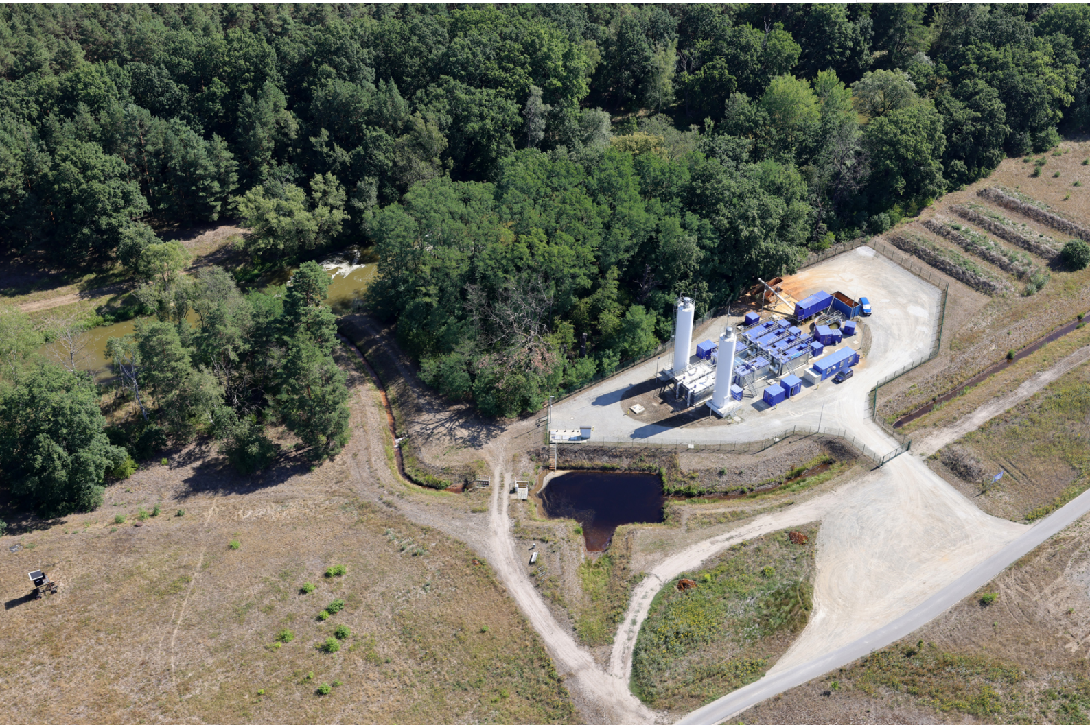
Modulare Wasserbehandlungsanlage (MWBA) Neustadt der LMBV
