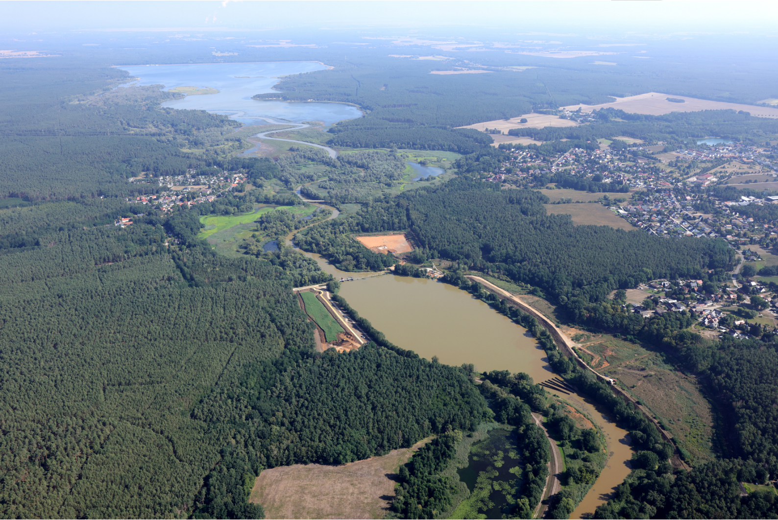
Blick auf die Vorsperre Bühlow
