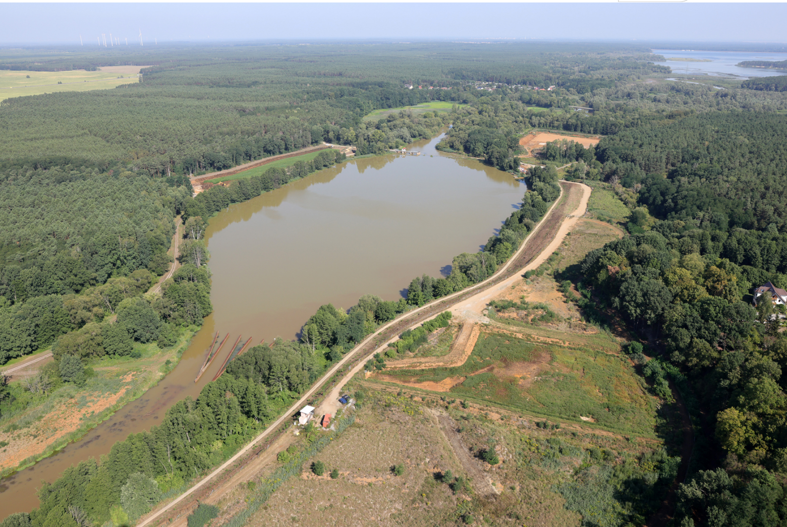
Sedimentationsbecken an der Vorsperre Bühlow
