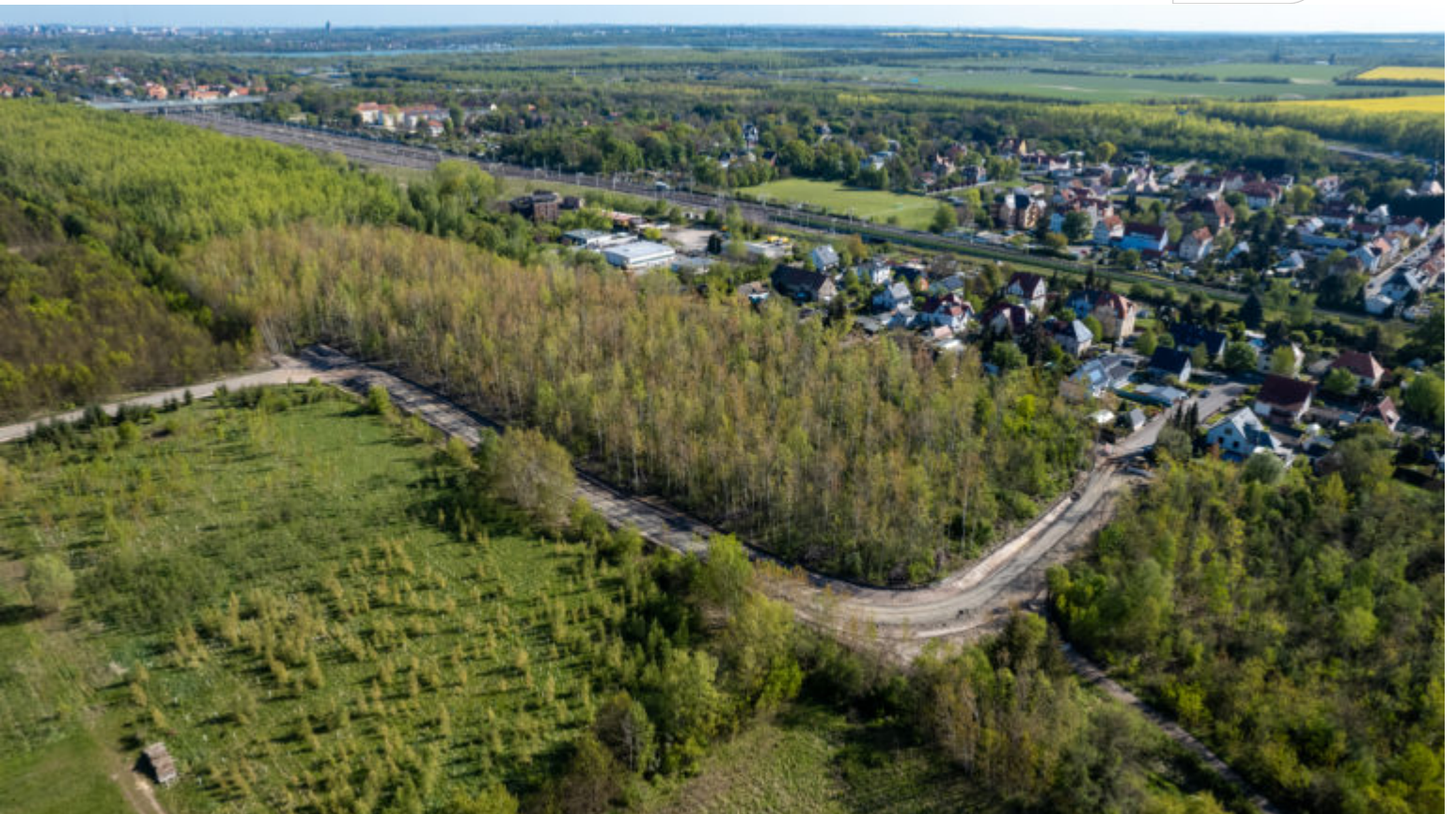
Anbindung an die Feldstrasse in Großdeuben (April 2024)
