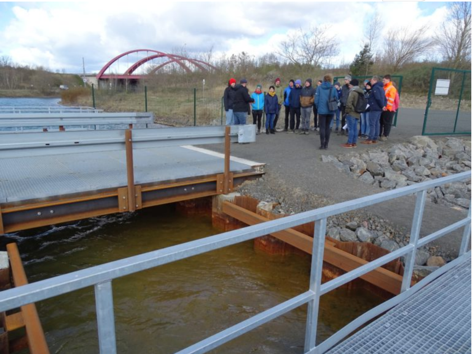
Erläuterungen am Querbauwerk oberhalb der Kanuparkschleuse
