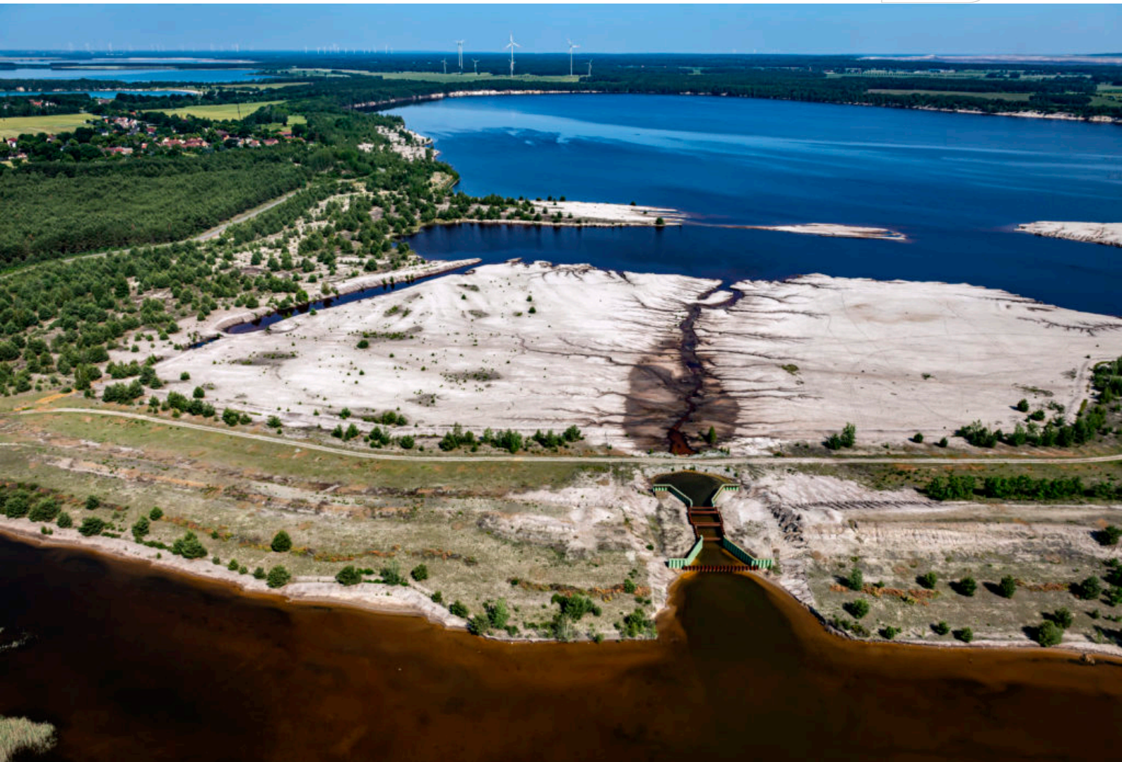
Archivbild: Lage des künftigen Überleiters 3a - Vor Beginn der Arbeiten
