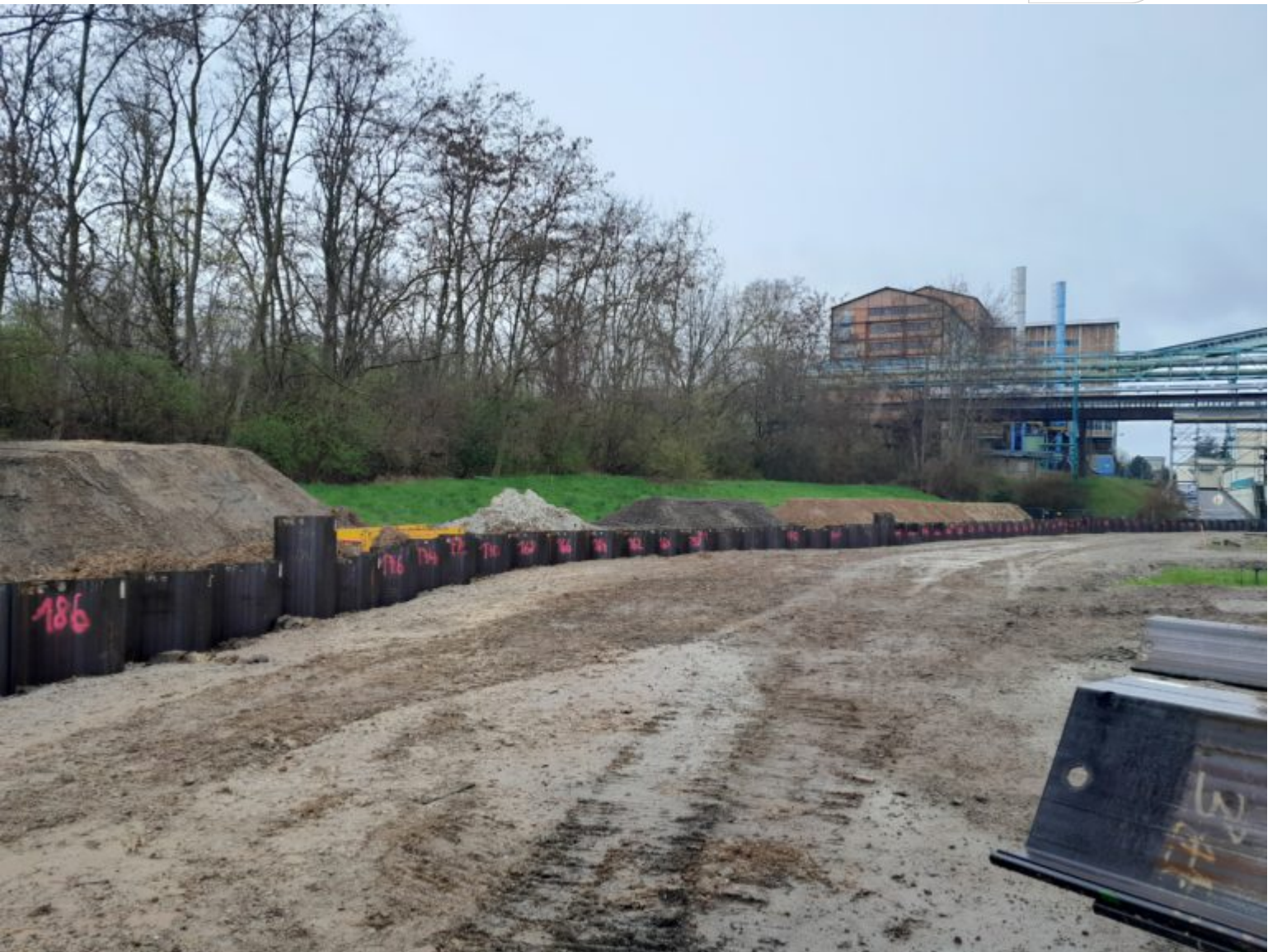
Einbau der einzelnen Spundwandbohlen für die Leitwand
