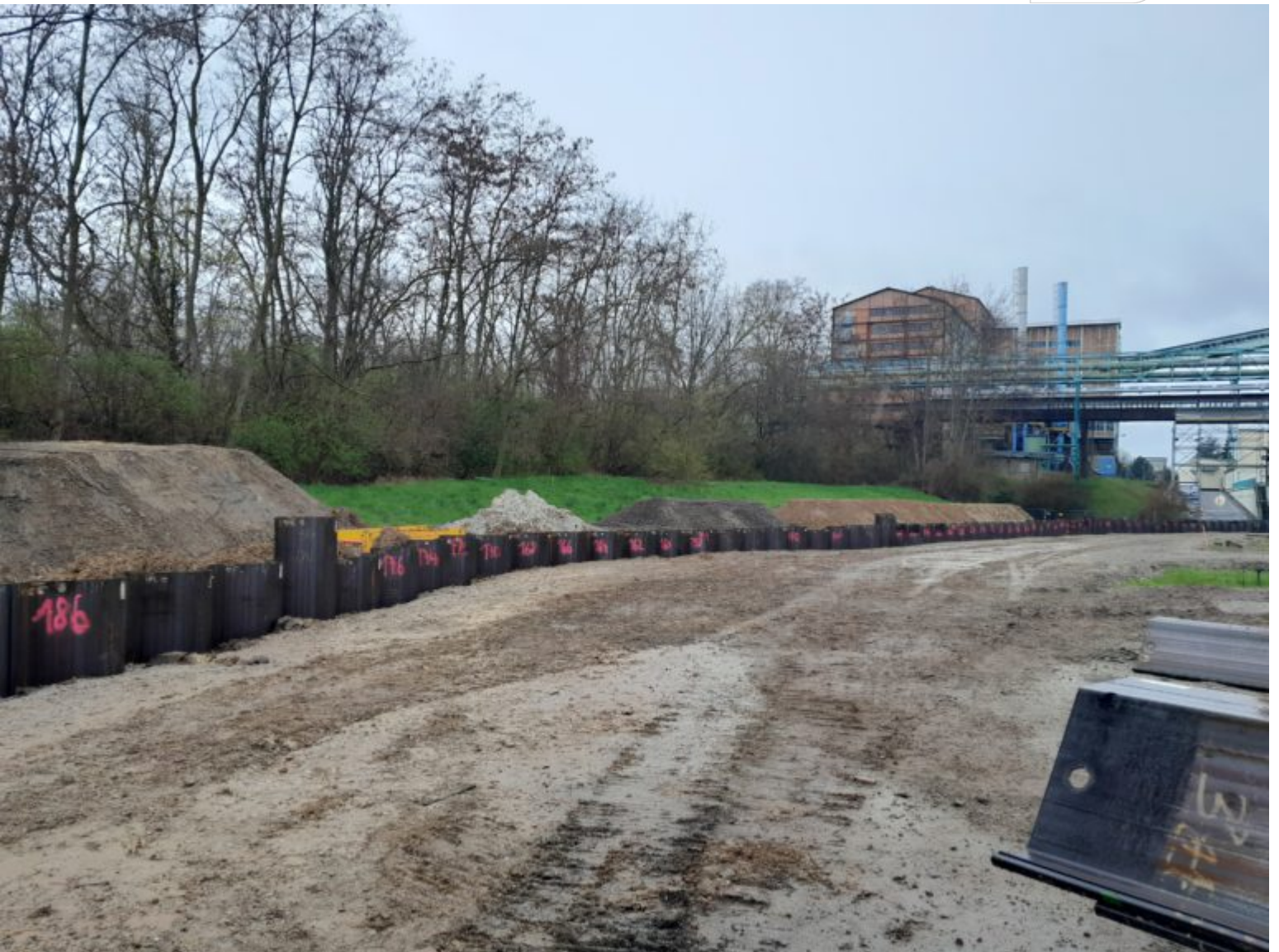
Einbau der einzelnen Spundwandbohlen für die Leitwand
