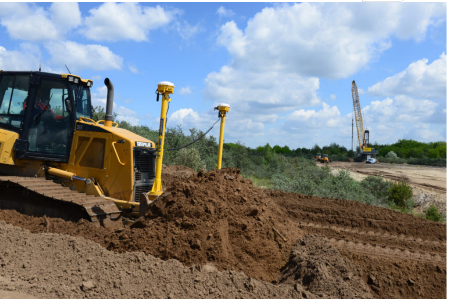
Großgeräte im Einsatz
