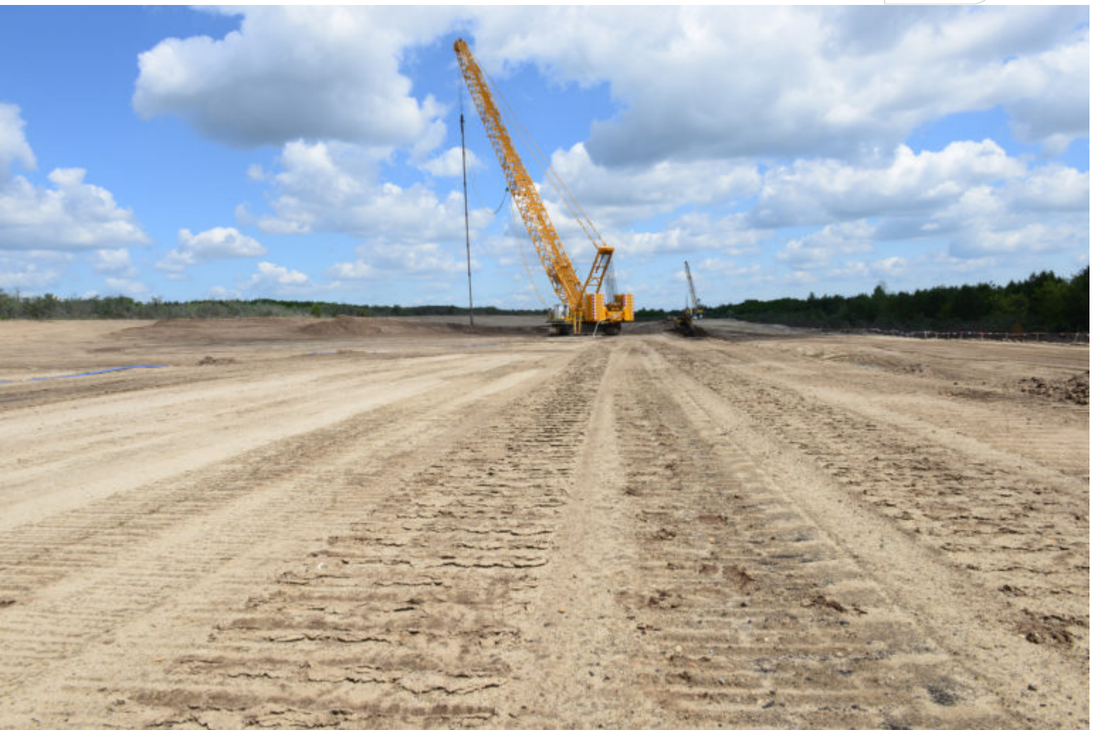
Bereits verdichteter Bereich
