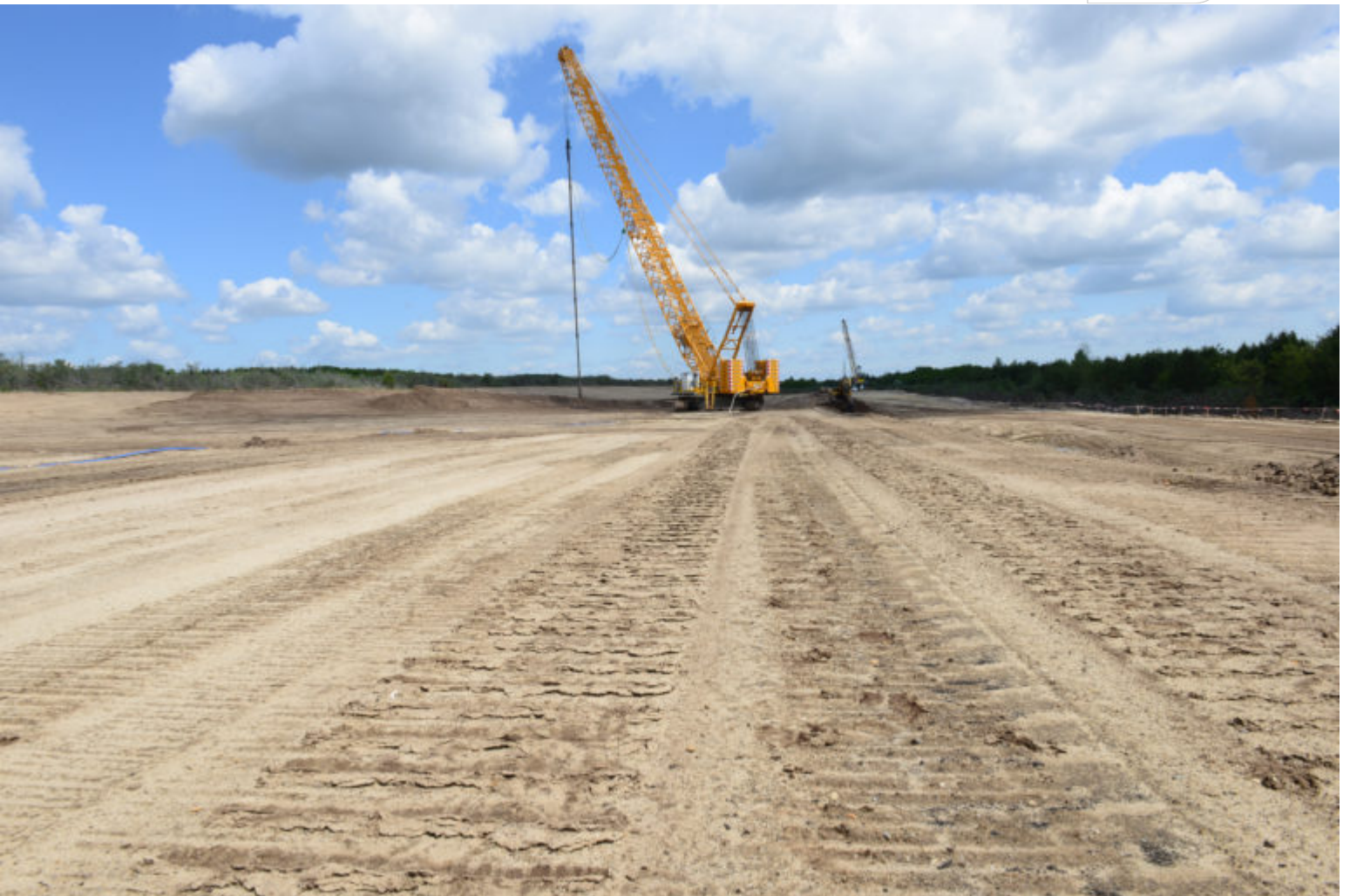
Bereits verdichteter Bereich
