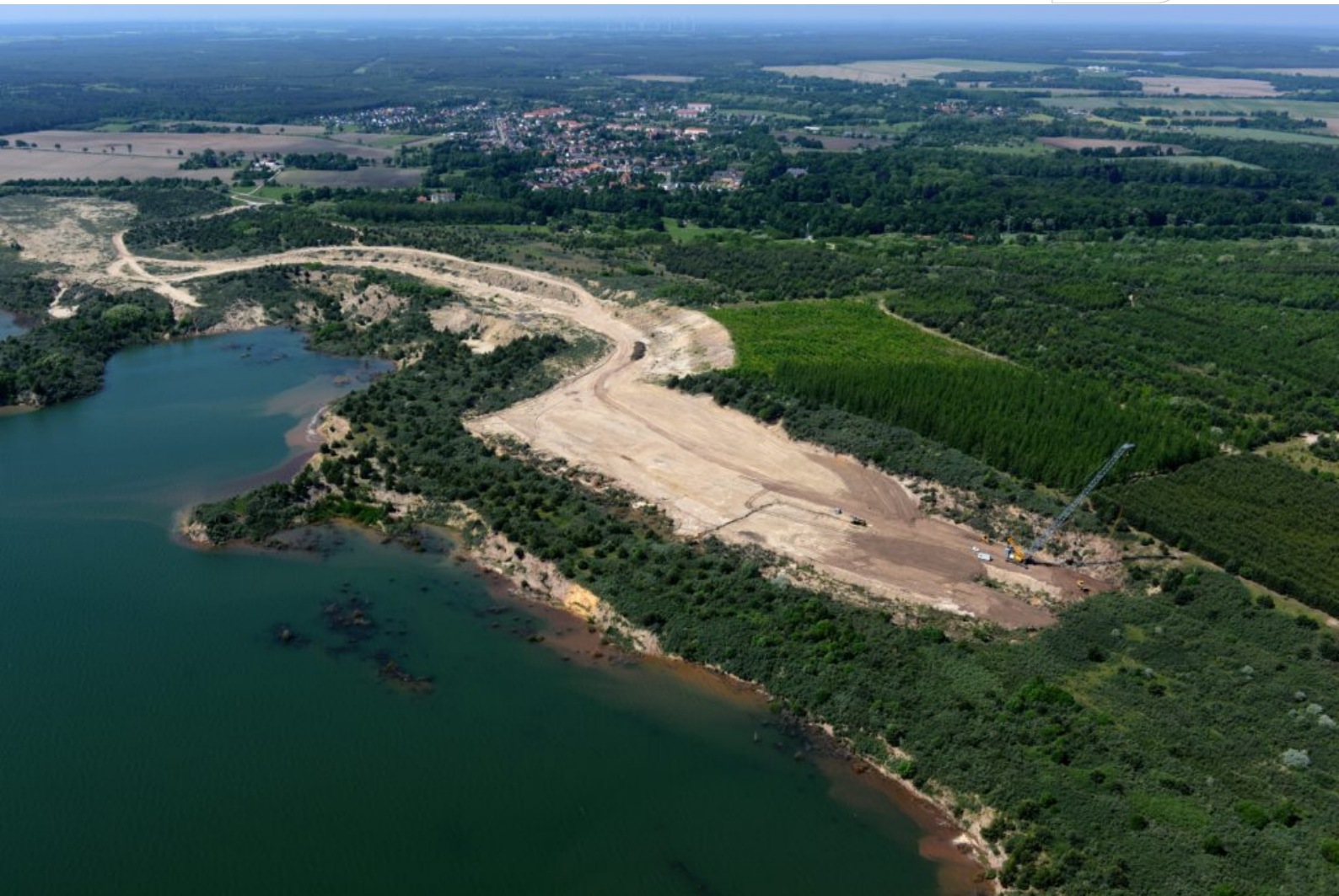
Archivfoto aus 2019: SW-Böschung des RL Greifenhain Impressionen der Sanierungsarbeiten
