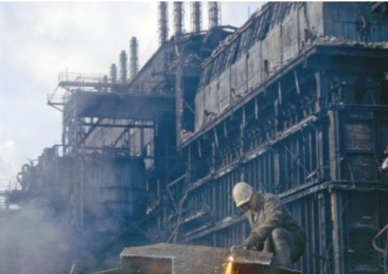
Abriss der Kokerei Lauchhammer (1993)
