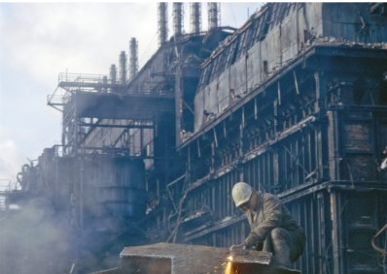
Abriss der Kokerei Lauchhammer (1993)
