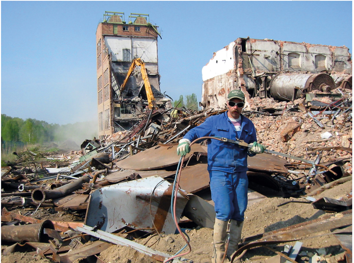
Abriss der Brikettfabrik Zechau (2004)
