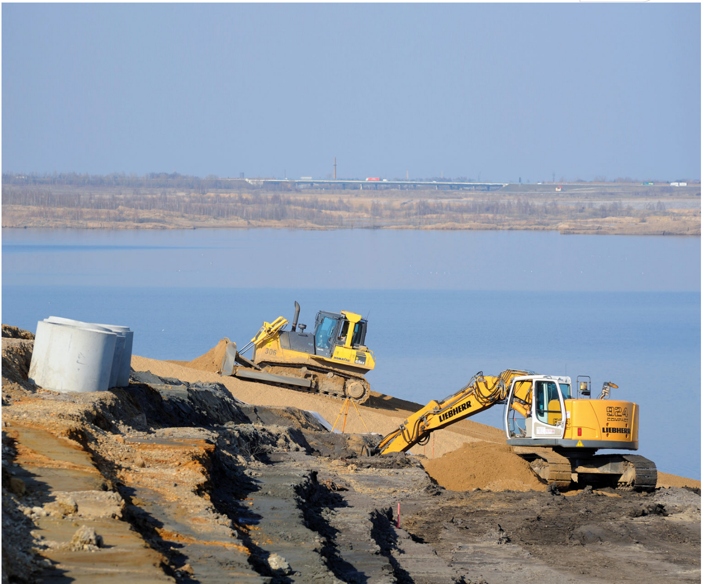
Bau des Überleiters von der Weißen Elster zum Tagebau Zwenkau
