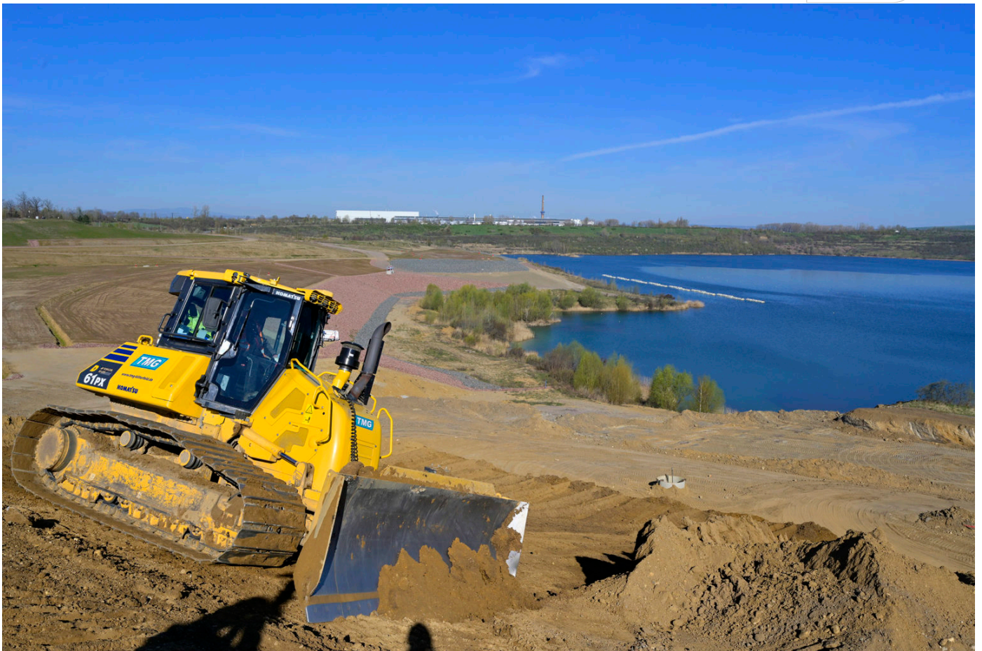
Sanierungsarbeiten an der Ostböschung im ehemaligen Tagebau Nachterstedt
