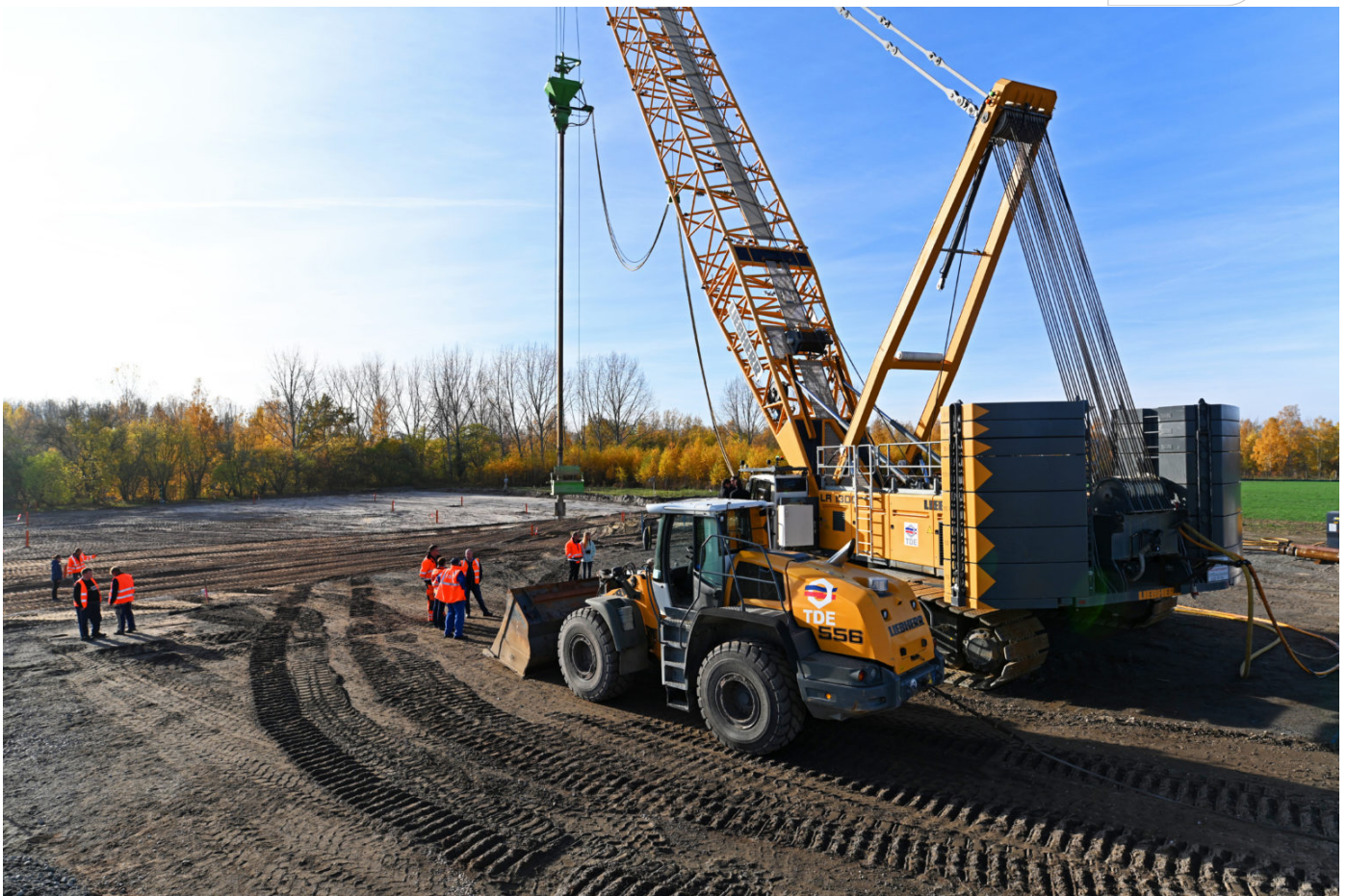
Sanierung der Hochkippe Borna durch Rüttelstopfverdichtung
