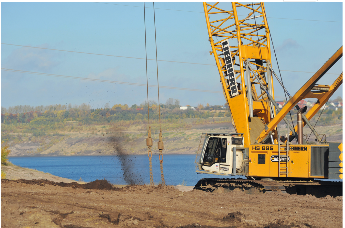
Fallplattenverdichtung im Tagebaurestloch Wulfersdorf
