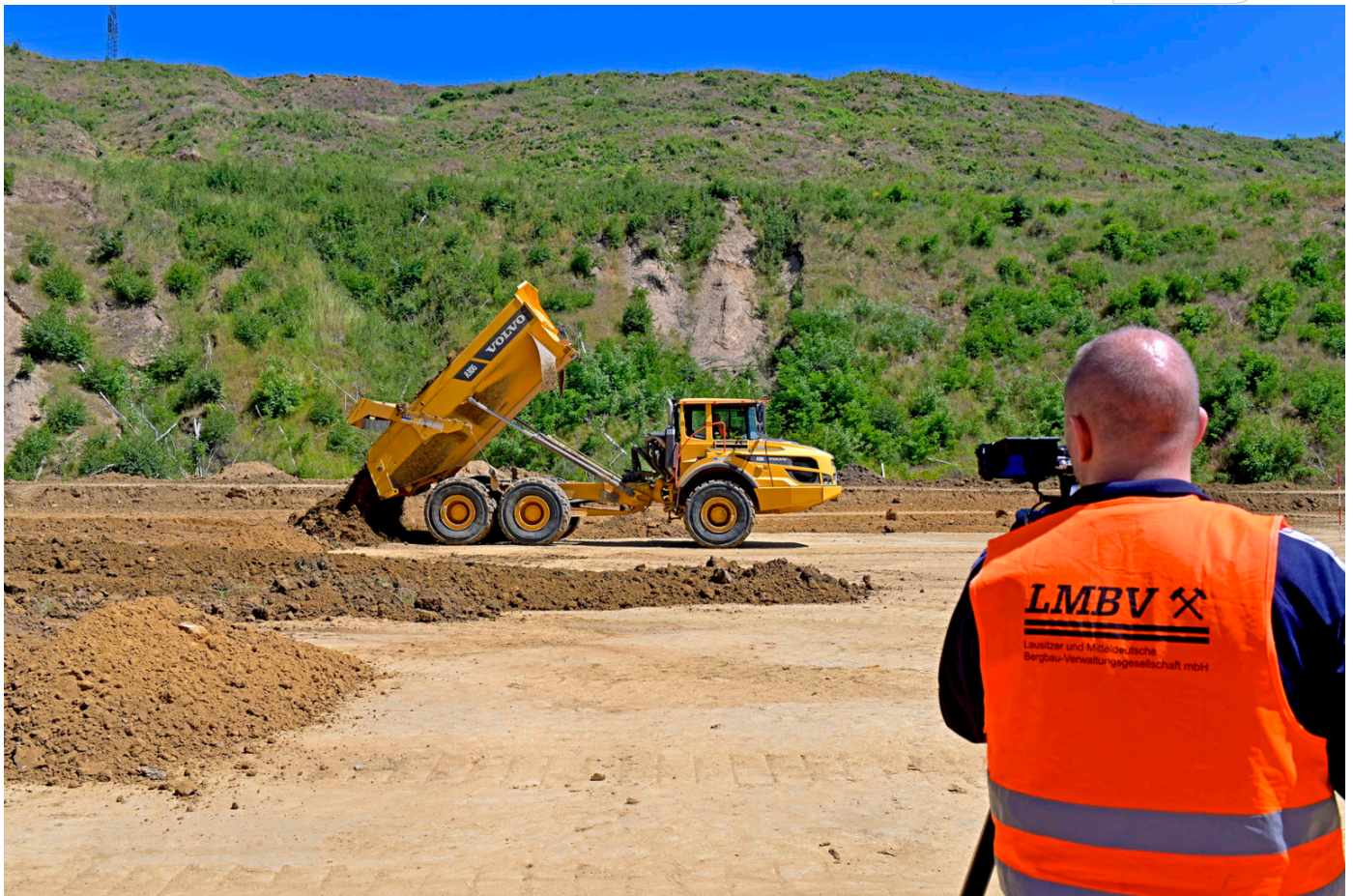
Anstützung einer Kippe im ehemaligen Tagebau Wulfersdorf
