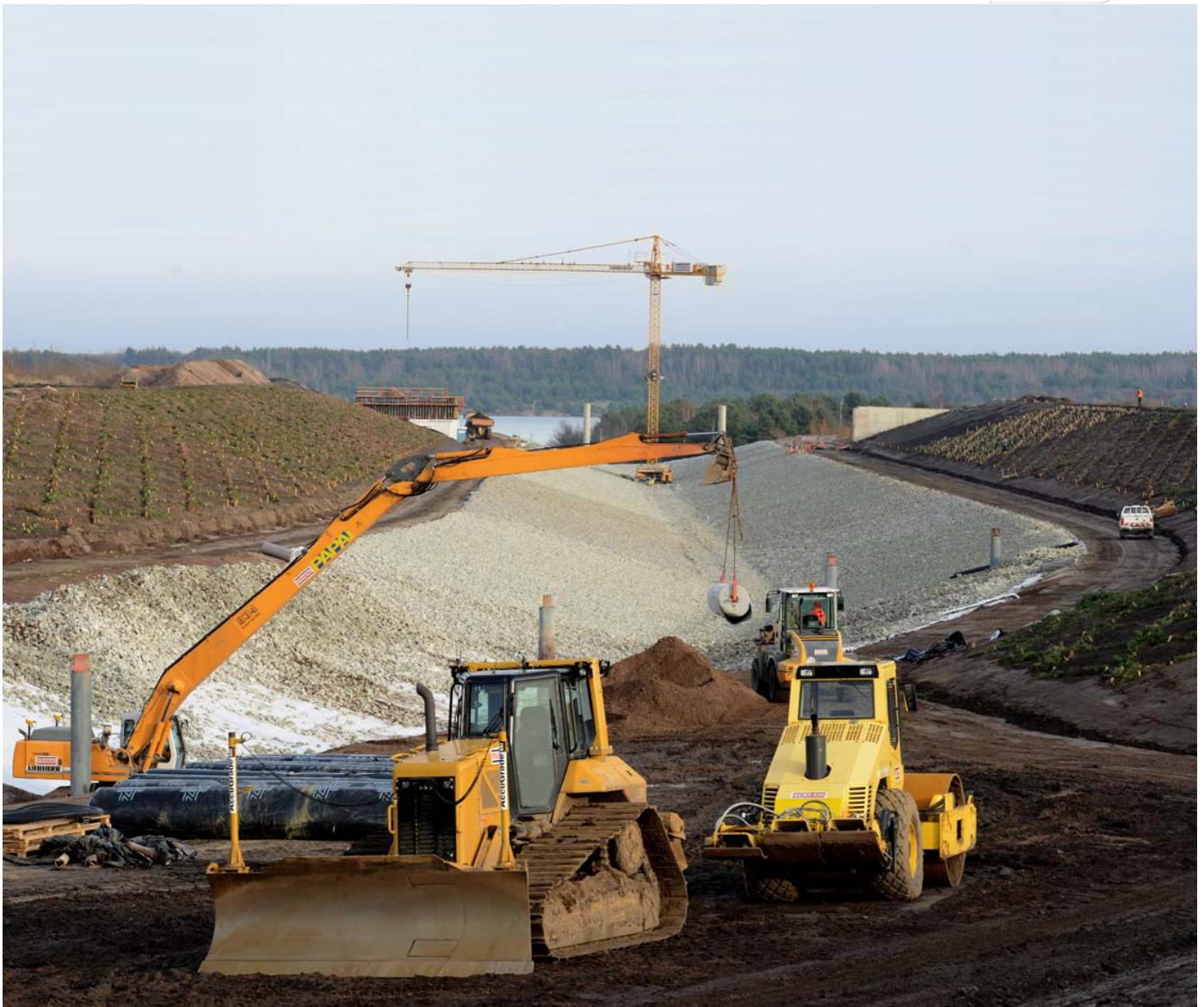
Bau des Überleiters 11 im Lausitzer Seenland
