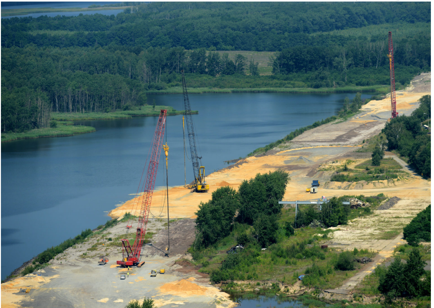
Rütteldruckverdichtung am Silbersee in der Lausitz
