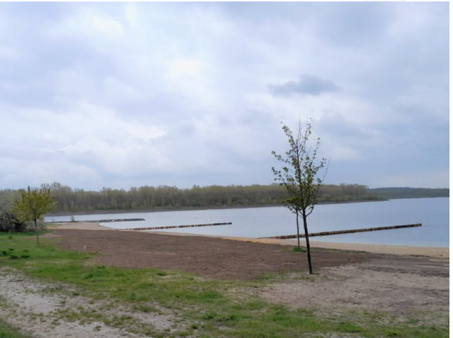
Blick in Richtung Auslaufbauwerk
