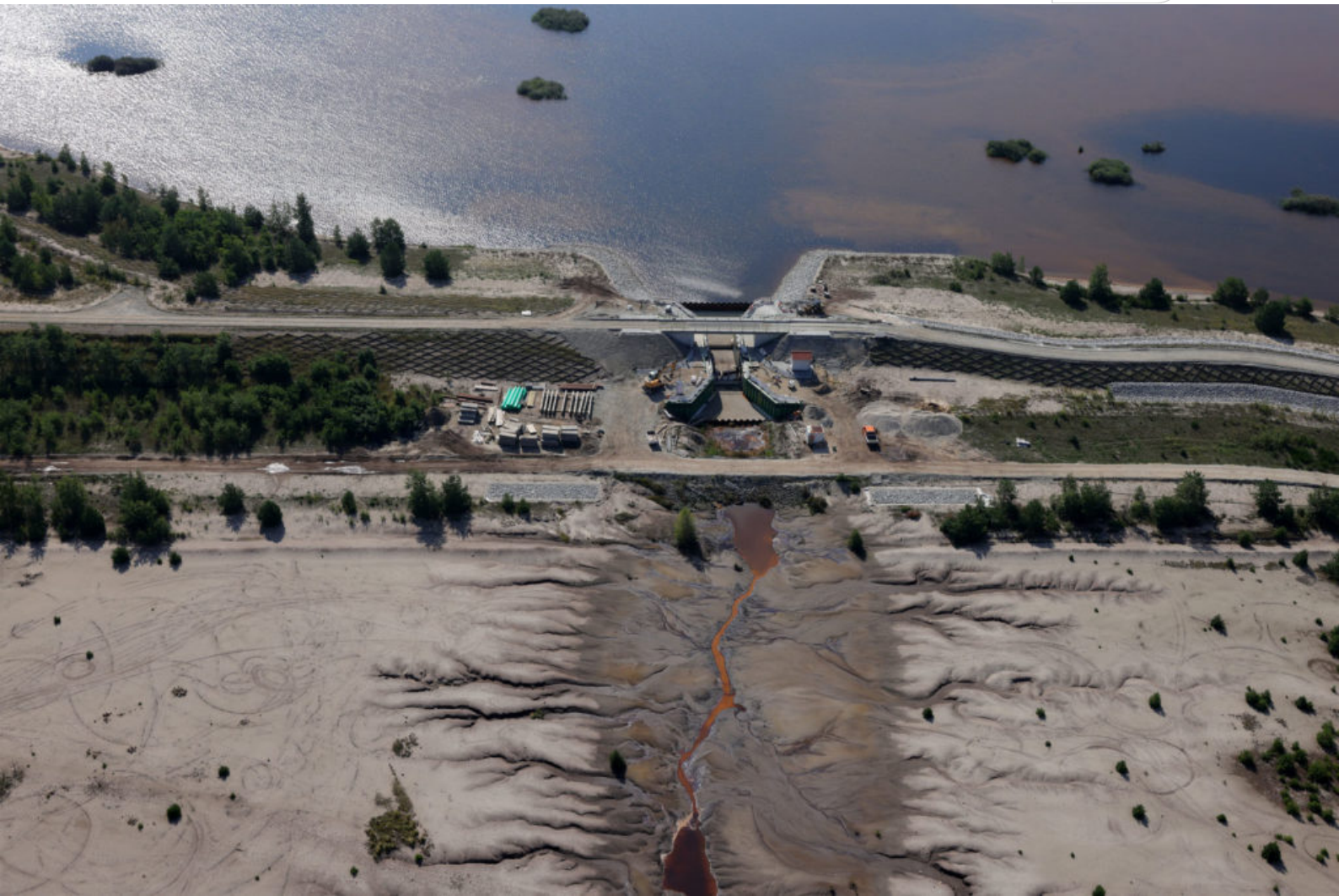
Blick auf Überleiter 3a zwischen Neuwieser See und Blunoer Südsee
