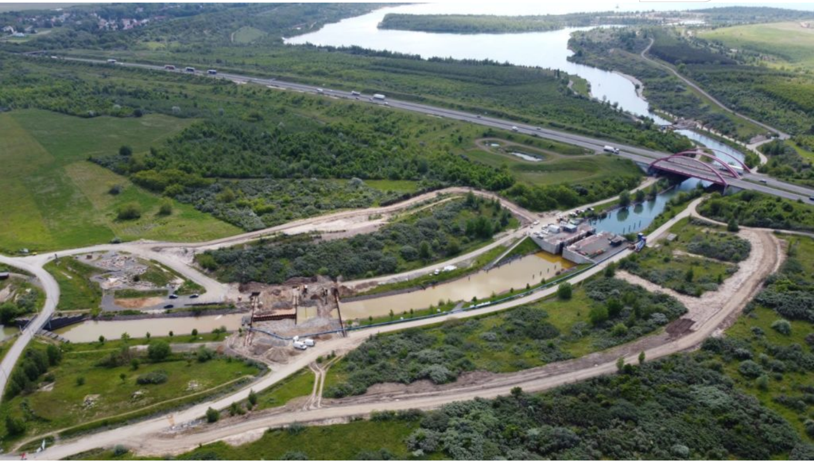
Luftaufnahme des Störmthaler Kanals mit beiden Querbauwerken, der Schleuse und der Brücke der A38
