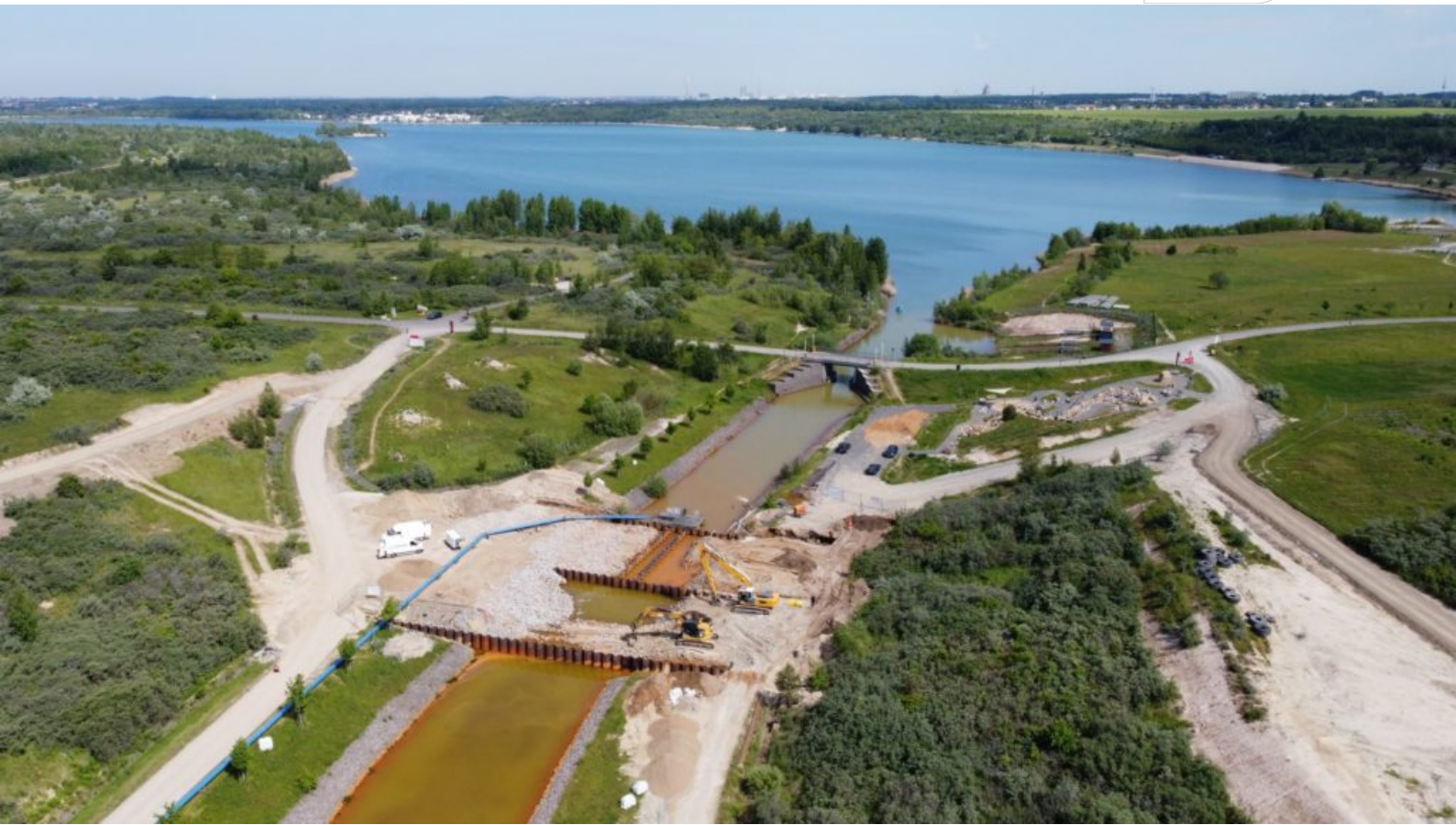
Unteres Querbauwerk in Richtung Markleeberger See
