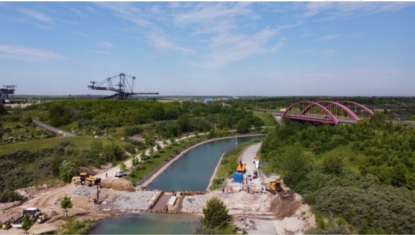
Das oberes Querbauwer ist fast fertig verfüllt, mit Wasserüberleiter in der Kanalmitte.
