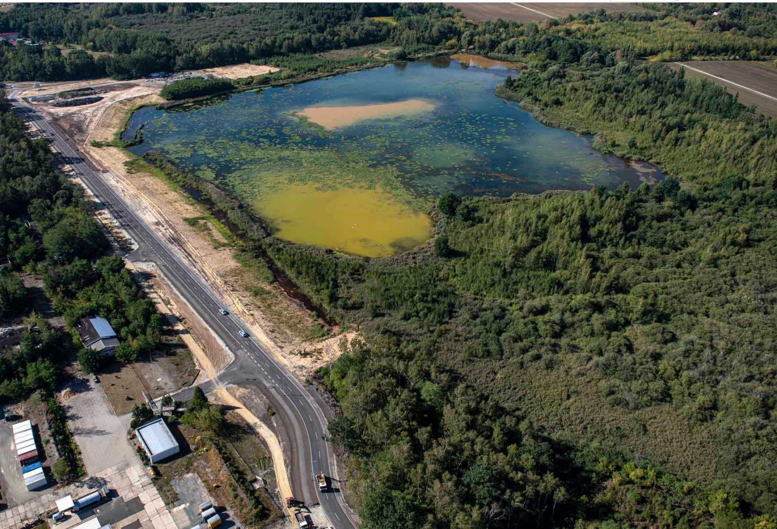
Ortrander Str. in Lauchhammer - 2019 während der Sanierungsarbeiten
