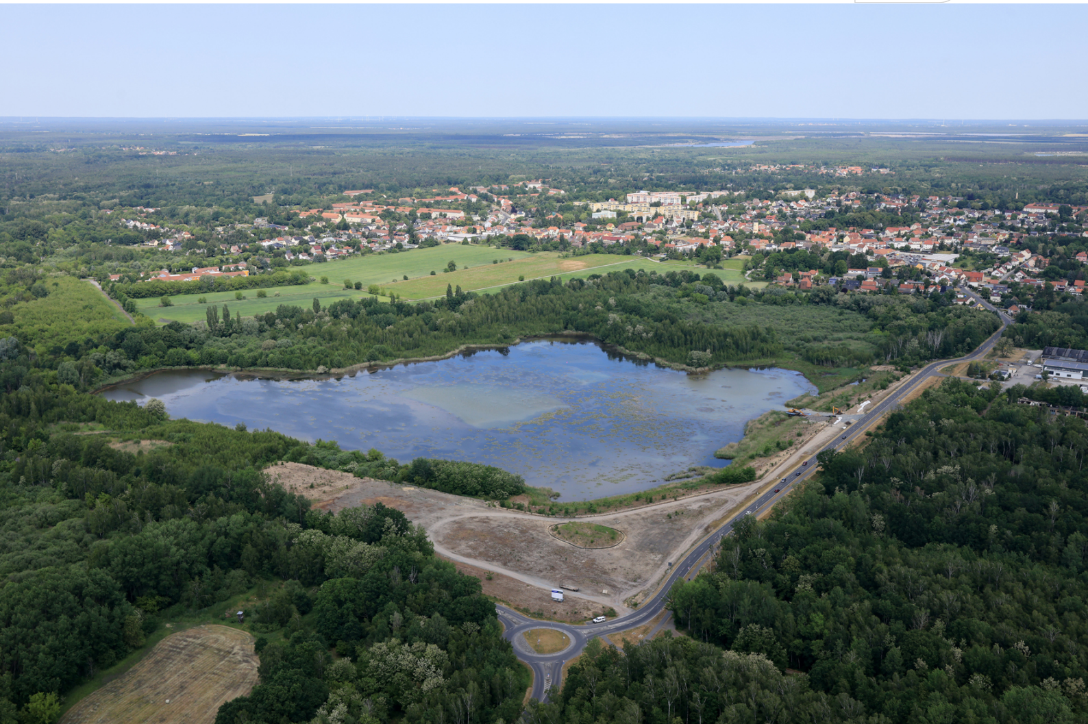
Sanierte Ortrander Straße in Lauchhammer – 2023
