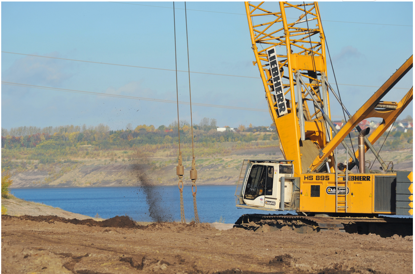
Fallplattenverdichtung im Tagebaurestloch Wulfersdorf
