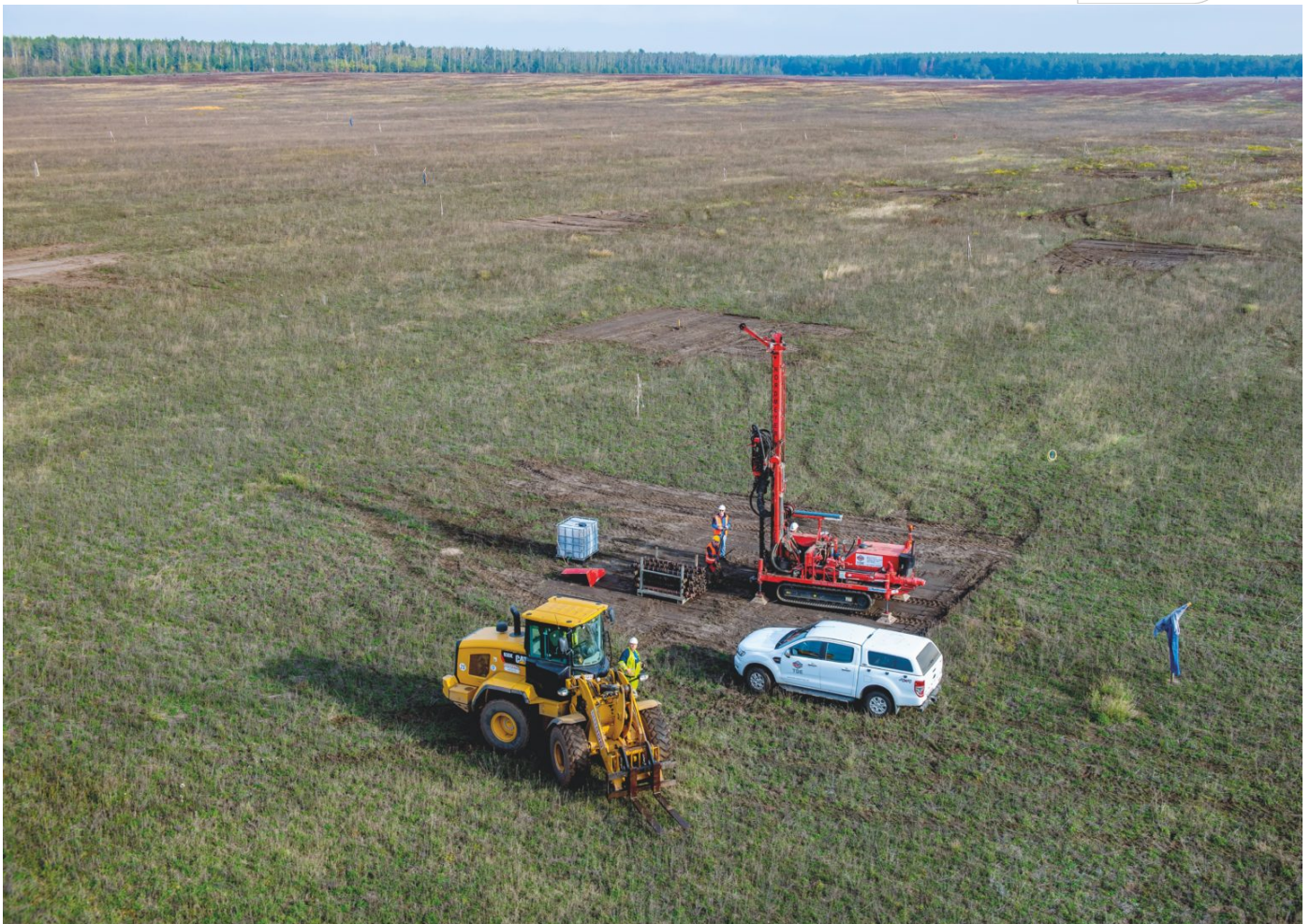
Schonende Sprengverdichtung auf der Innenkippe des Sanierungstagebaus Spreetal
