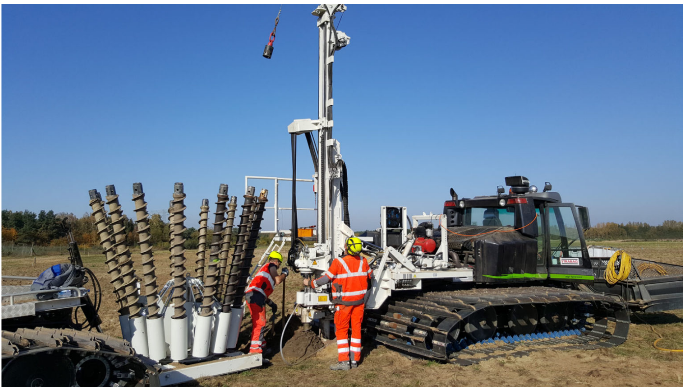
Bohren der Sprengbohrlöcher für die Schonende Sprengverdichtung
