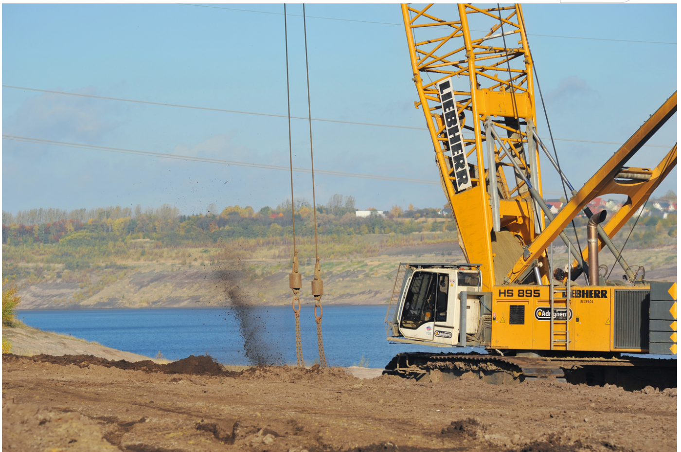
Fallplattenverdichtung im Tagebaurestloch Wulfersdorf
