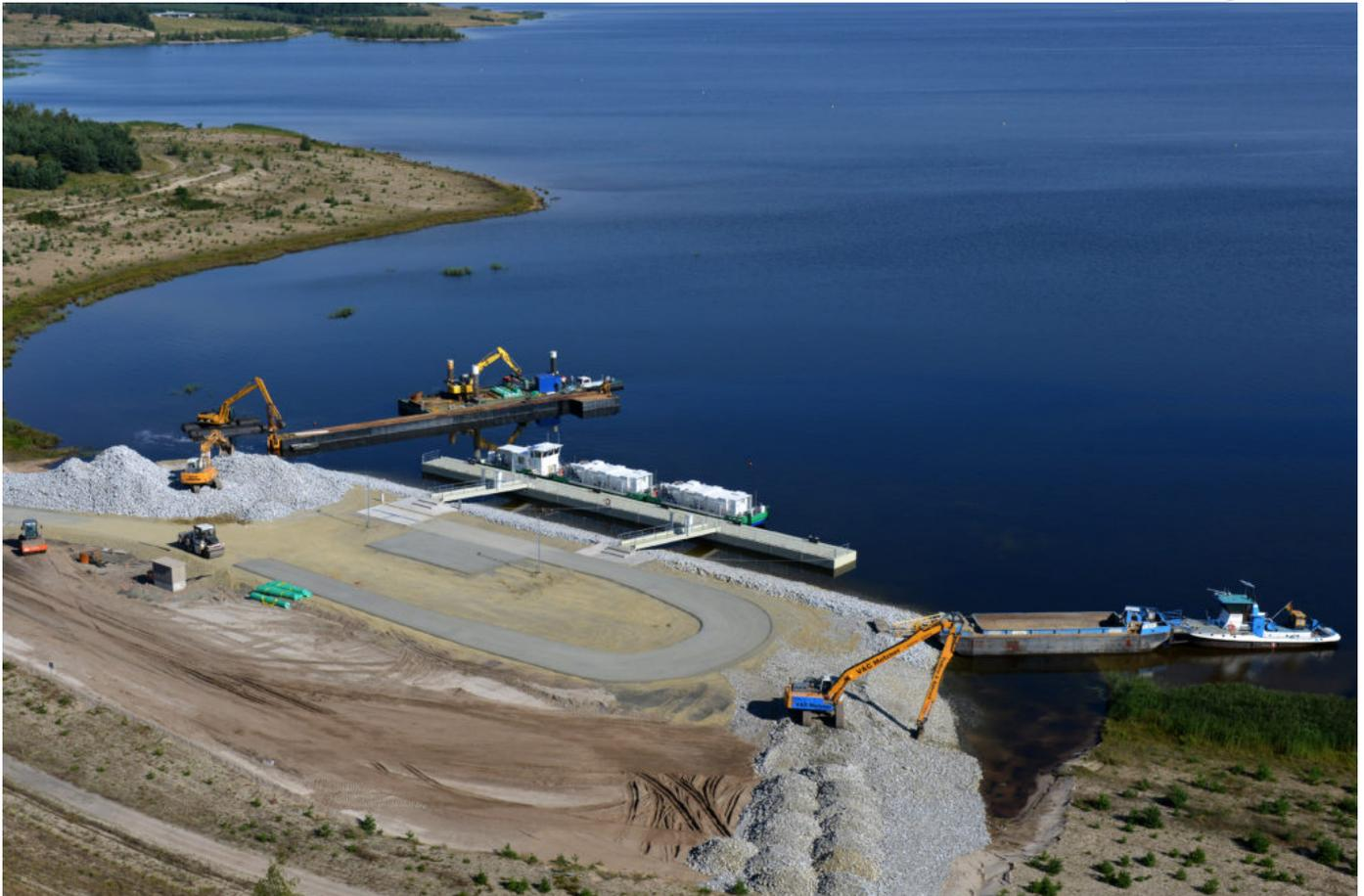
So genannte Einsetz- und Beladestellen, wie die an der Südwestböschung des Partwitzer Sees, dienen dazu das Sanierungsschiff zu Wasser zu lassen oder wieder aus dem Wasser heraus zu befördern. Auch die Beladung mit Kalk, der über eine Leitung in die Leichter des Sanierungsschiffes gepumpt wird, geschieht in diesem Bereich.
