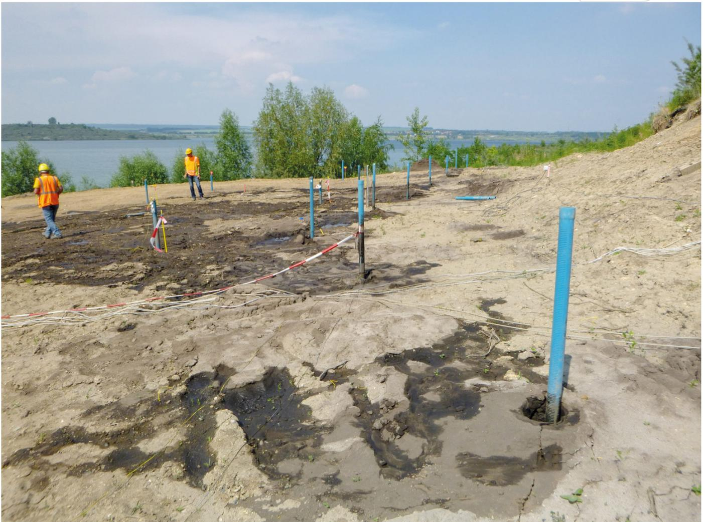
Sprengbohrlöcher für die Schonende Sprengverdichtung
