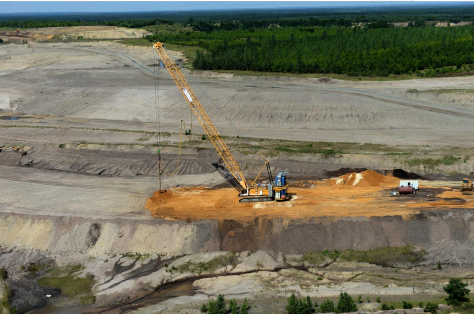
Rütteldruckverdichtung in den Tagebaufeldern Lauchhammer
