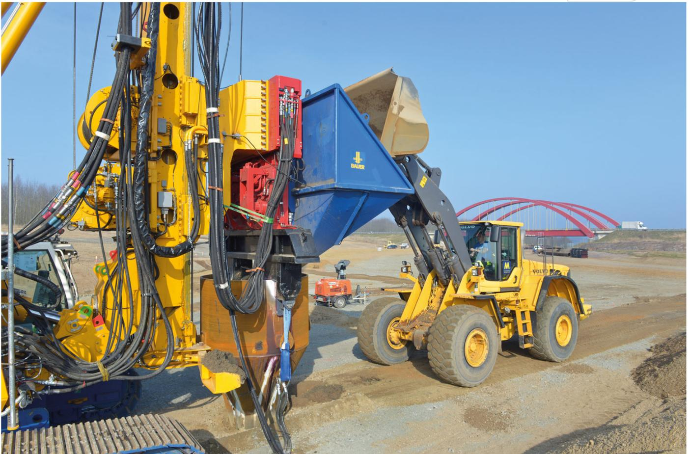
Rüttelstopfverdichtung als Vorbereitung zum Bau der schiffbaren Verbindung zwischen Zwenkauer und Cospudener See
