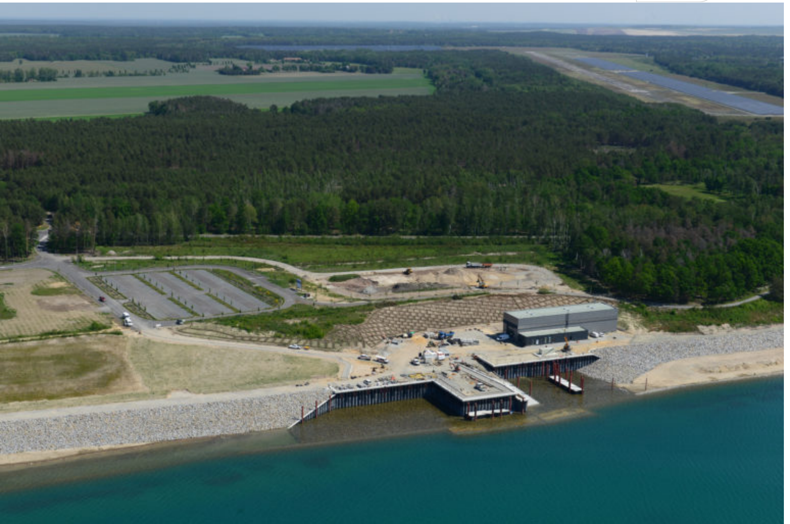
Sanierungsstützpunkt von oben (Juni 2021)
