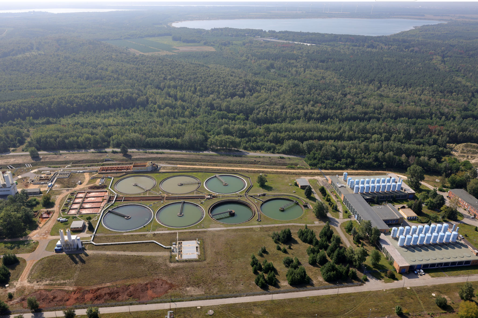
Grubenwasserreinigungsanlage Schwarze Pumpe
