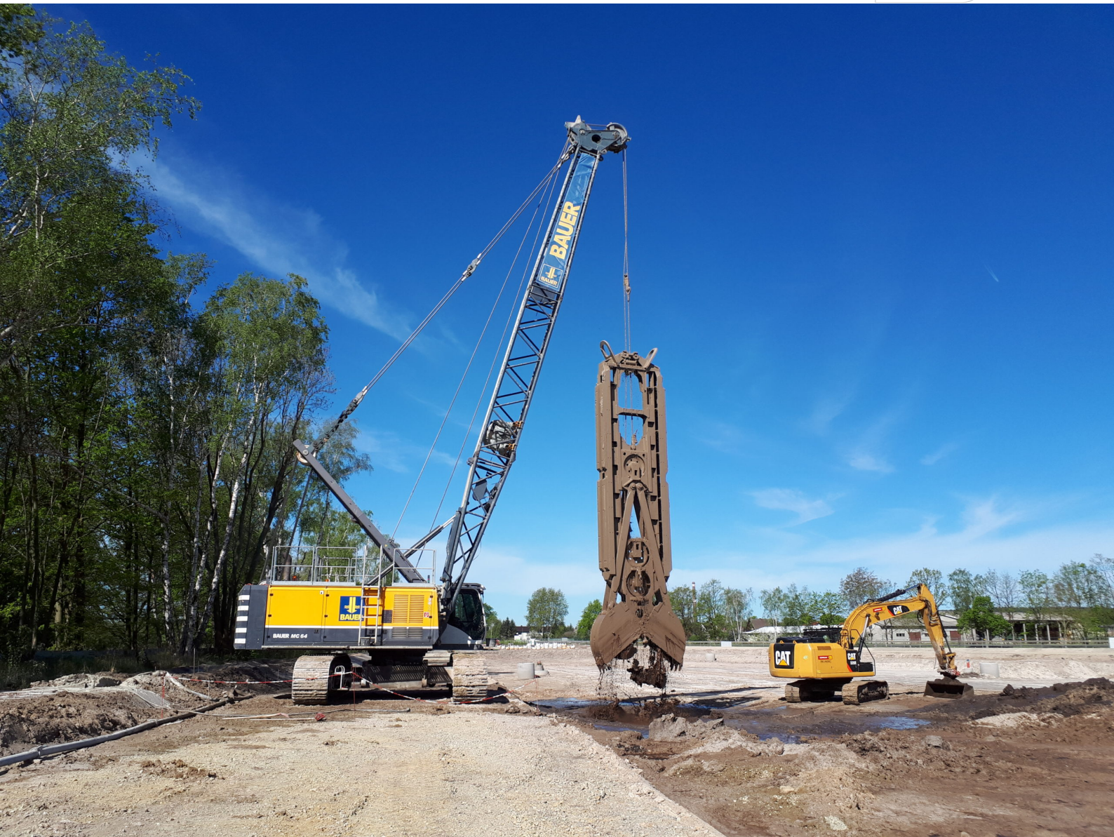
Herstellen einer Dichtwand (Symbolfoto)
