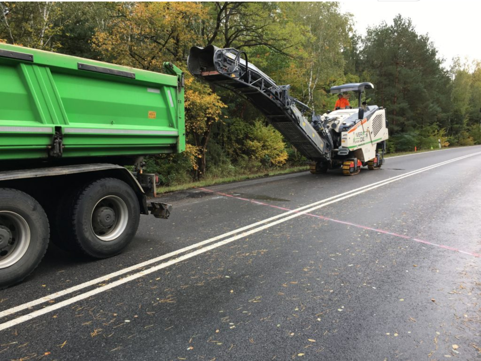
Asphaltfräsarbeiten auf dem gesperrten Abschnitt der B97
