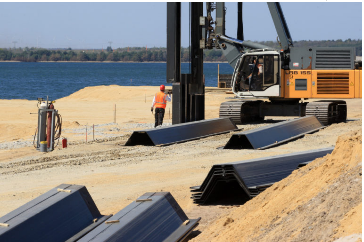
Sedlitzer See Arbeiten im Auftrag der LMBV am zukünftigen Hafen des Sedlitzer Sees
