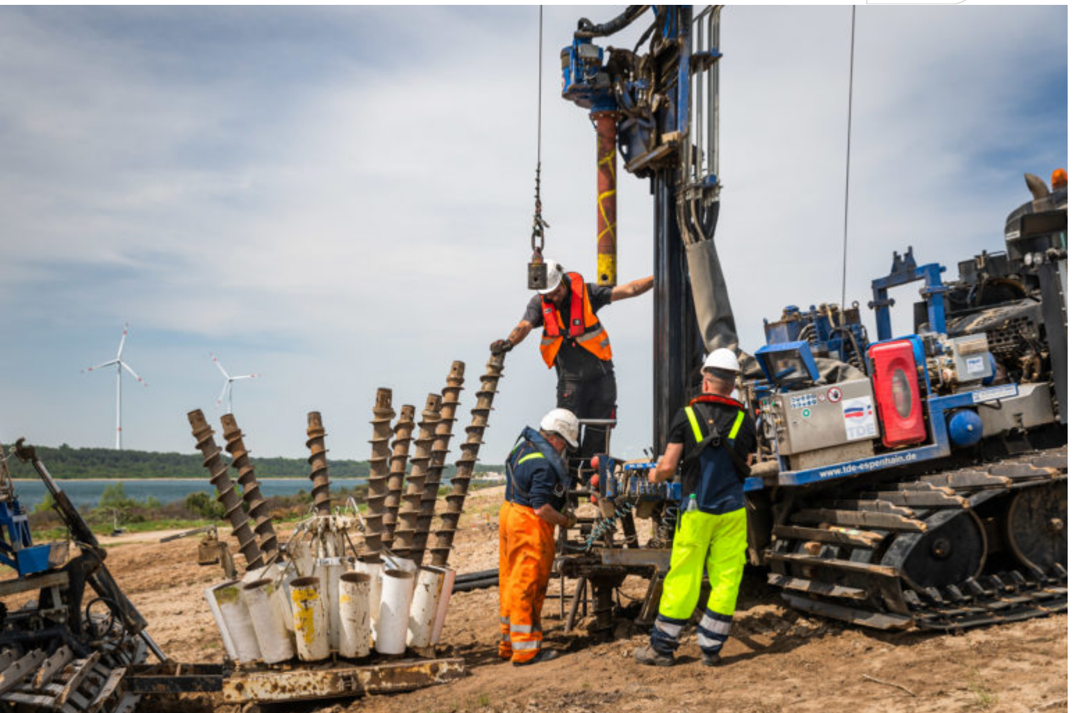
Beispiel für Schonende Sprengverdichtung
