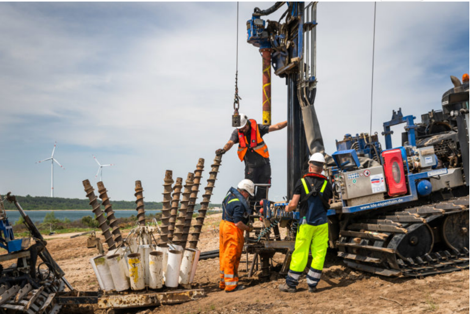
Beispiel für Schonende Sprengverdichtung
