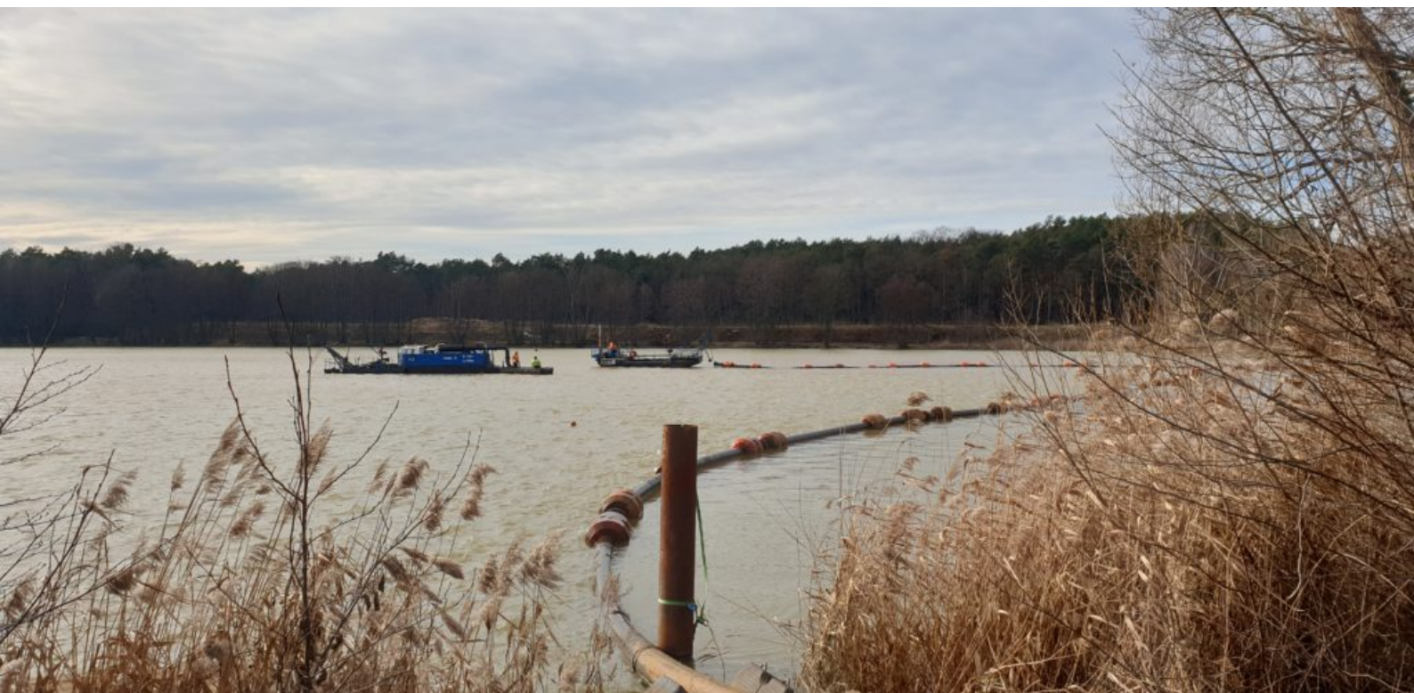
Saug-/Spülbagger auch 2021 auf der Vorsperre Bühlow im Einsatz
