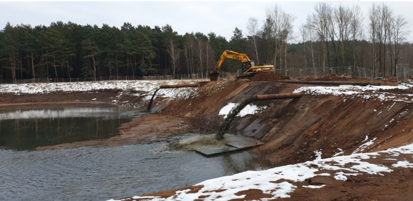
Das Einspülen in des Sedimentationsbecken begann am 25.01.2021
