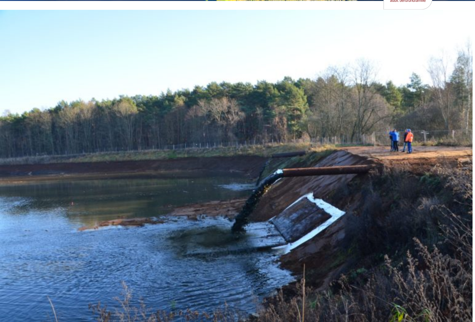
Sedimentationsbecken wird wieder befüllt
