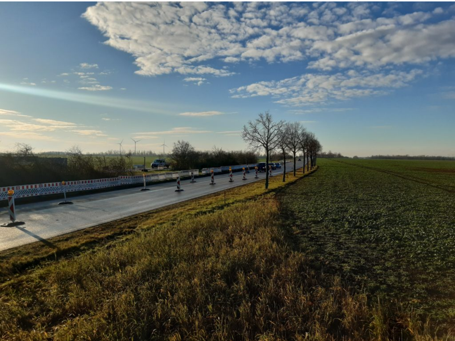
Die halbseitige Sperrung zwischen Blumroda und Borna ist seit dem 16.12.2024 wieder aufgehoben. Ein Einblick in die Arbeiten kurz vor Freigabe der Straße. (Fotos: LMBV)
