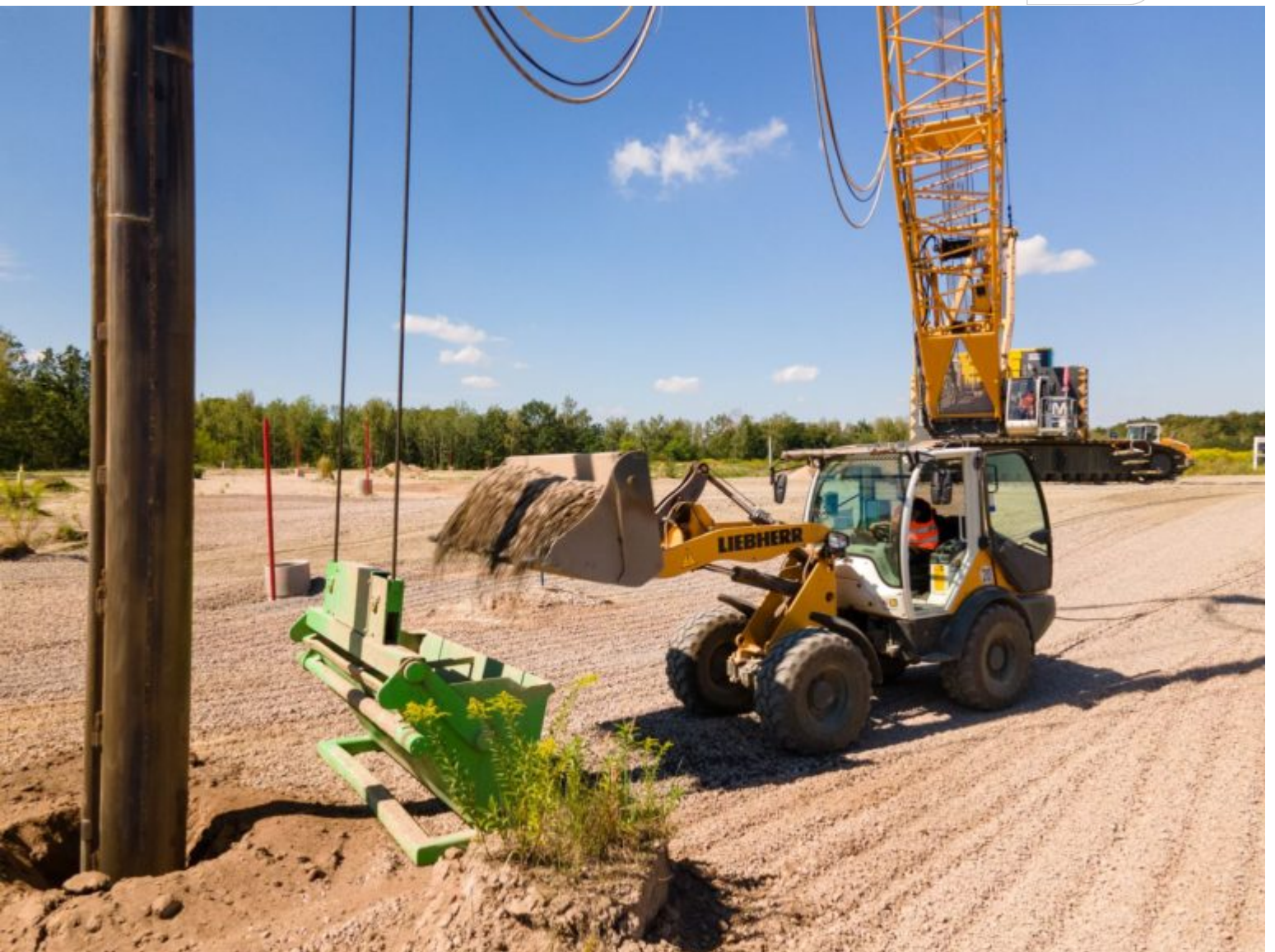
Vorführung der RSV-Technik, Bild vom diesjährigen Baustellentag
