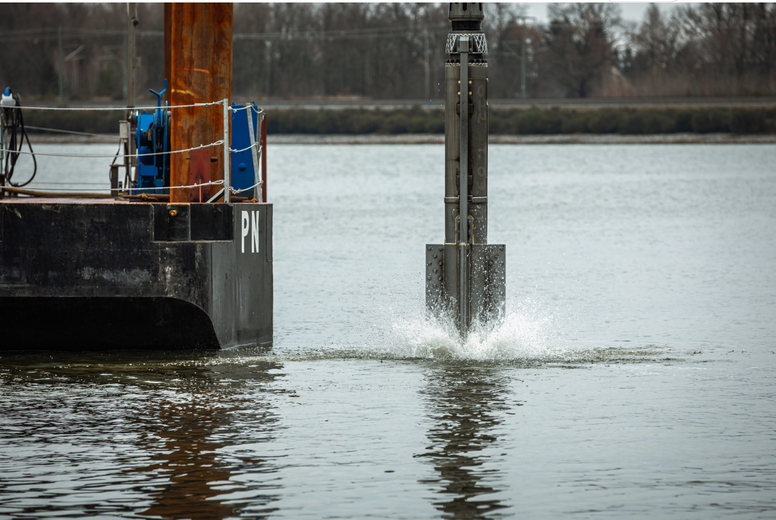
Test zur Rütteldruckverdichtung am Silbersee - Einbringen des Rüttlers
