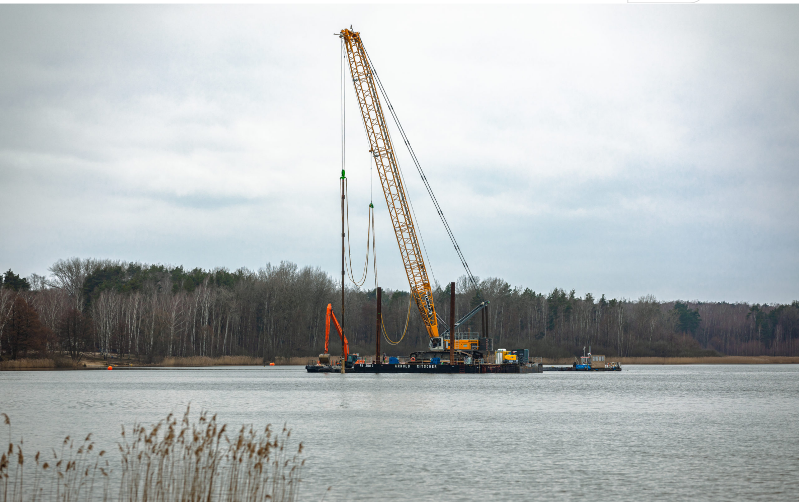
LMBV: Rütteldruckverdichtung-Testfeld Silbersee
